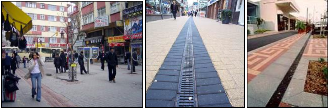
Şekil 4.27 a- İstanbul- Şirinevler – Mareşal Fevzi Çakmak Yayaştırılmış Sokağı (Fotoğraf: Günseli Döllük) b- Straatmeubilair- Hollanda ( www.escaholland.nl ), c- yaya yolu drenaj oluşu ( www.acoaus.com.au/streetsc )
