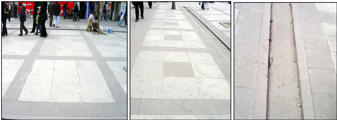
Şekil 6.13.: 58. Bulvar Caddesi orta aksı yer döşemesi görünümü b- yan yaya aksı yer döşemesi görünüm b- Drenaj taşı sert zemin derzleri görünümü (Fotoğraf: Günseli Döllük)
