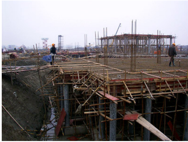
Şekil 3.14: Üzerine pistin inşa edildiği kazıklar [35]
