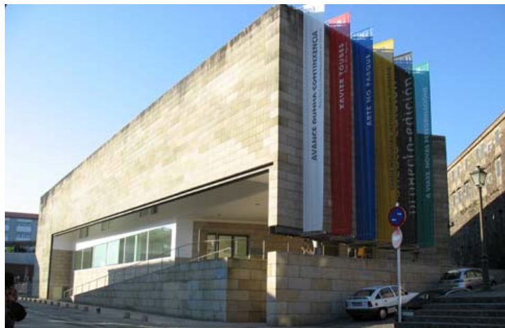
Şekil 4.16: Çağdaş Sanatlar Merkezi, Santiago de Compostela
