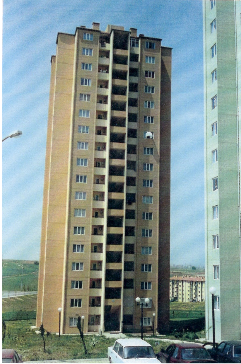
Şekil 5.15: B Tipi Blok Dış Görünüş
