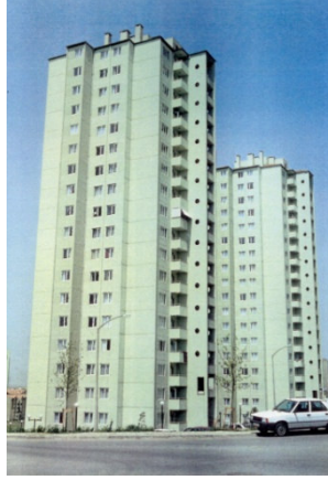
Şekil 5.14: A Tipi Blok Dış Görünüş
