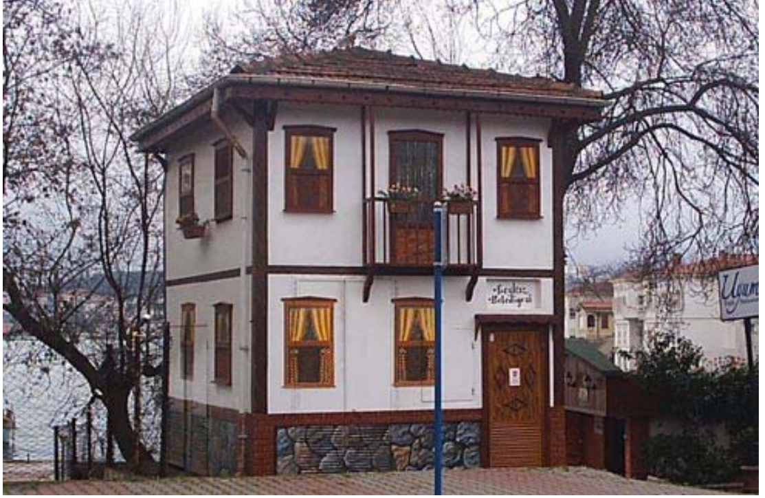
Şekil 2.3: Beykoz’da Geleneksel Türk evi biçimli trafo
