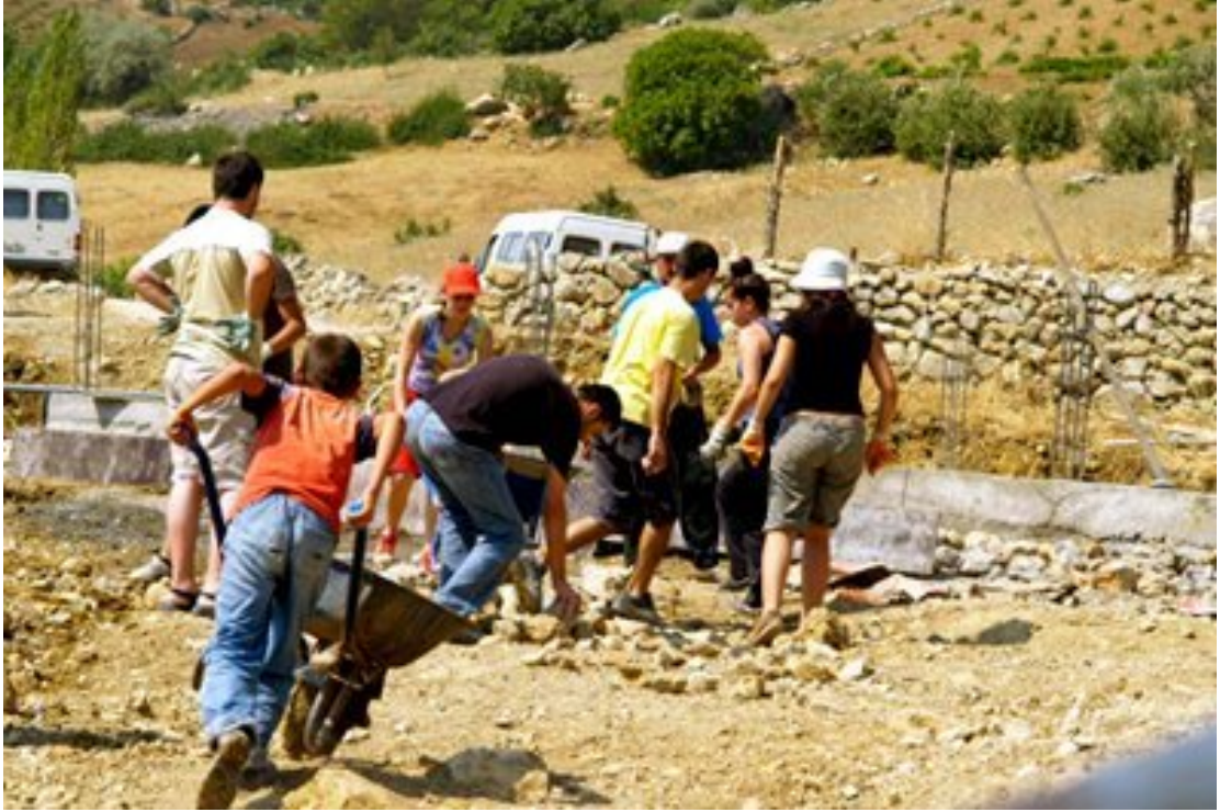
Şekil 3.20: Kahramanmaraş Ölçek 1'e 1 Şantiye Çalışması
