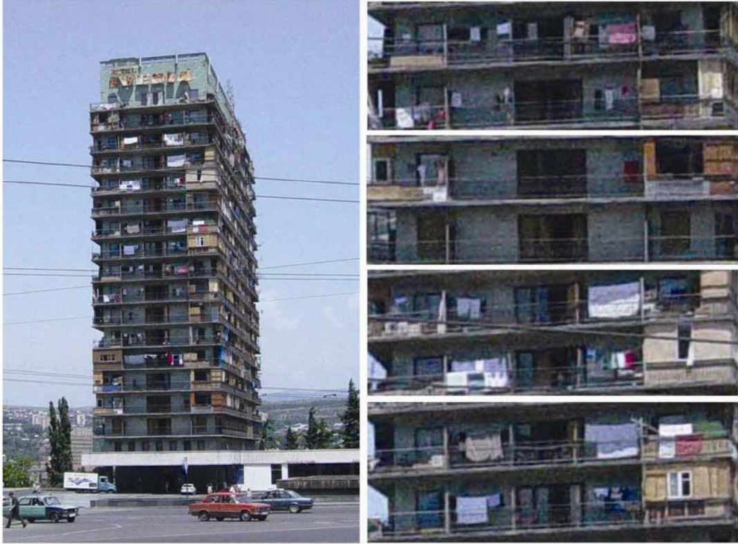
Şekil 1.1. : Gürcistan'da geçici süreliğine göçmenlere bırakılan yapı.
