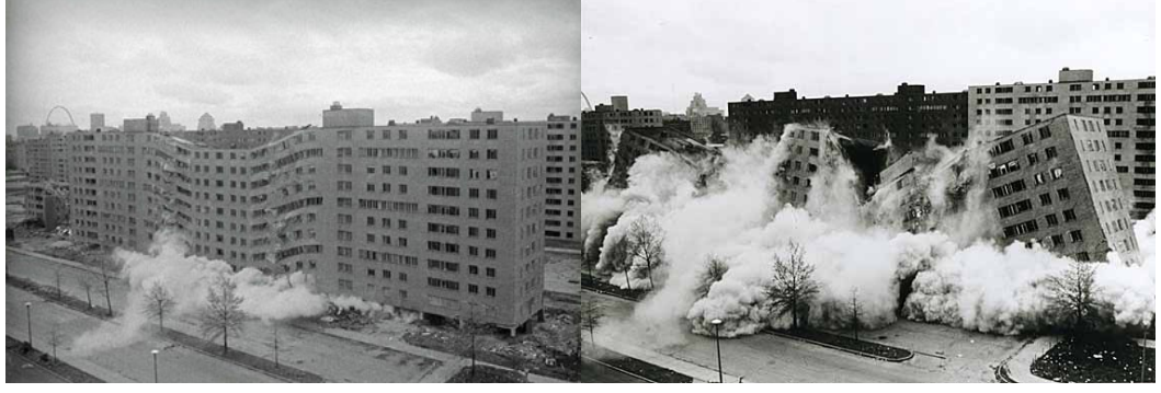
Şekil 2.10. : Pruitt Igoe Mahallesi Toplu Konutları. Yıkım Fotoğrafları.
