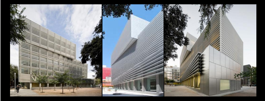
Şekil 5.42: Tesorería Sosyal Güvenlik Merkez Binası Fotoğrafları Kolajı, (Url-31).
