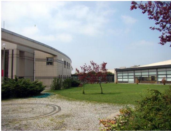
Şekil 4.3 : İTÜ Vakfı Dr. Sedat Üründül Anaokulu ana bina ve ek bina bağlantı koridoru.
