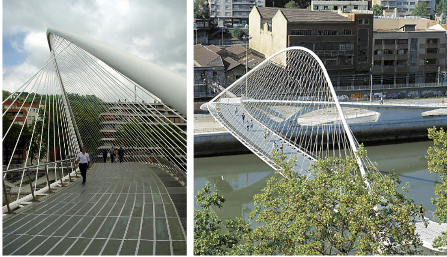
Şekil 4.19 Zubizuri Yaya Köprüsü, 1997
