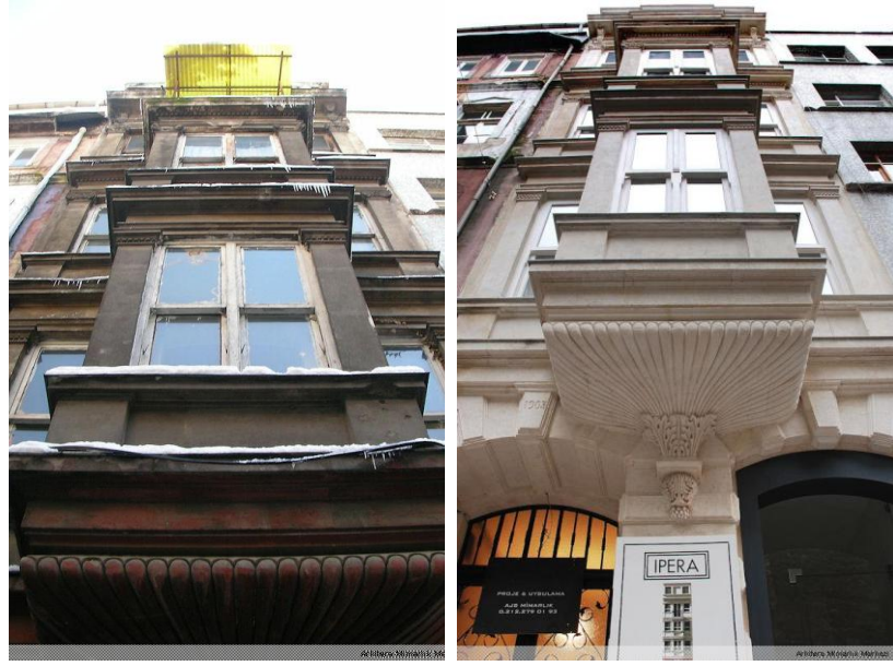
Şekil 5. 44: İpera 10 binasının restorasyon önce ve sonra ön cepheleri.
