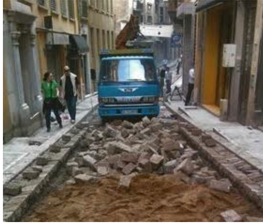
Şekil 5. 60: Serdar-ı Ekrem caddesinde eski asfaltın yerine taş döşenmesi.
