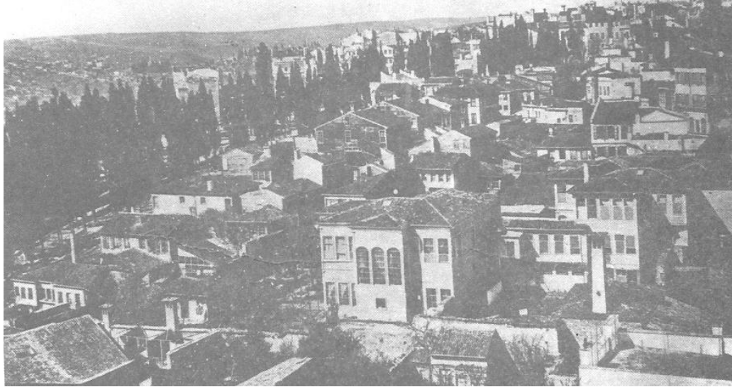
Şekil 3. 3: Büyük Hendek Sokağı civarı (Çıracı ve Dökmeci, 1990).
