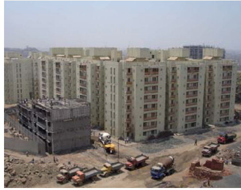
Şekil 5.67 : Bombay da yeni inşa edilen apartmanlar (Sorabjee, 2008).
