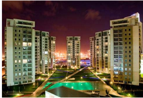
Şekil 5.113 : TAGO Mimarlık tarafından tasarlanan Incity konut yerleşkesi, Kozyatağı - Ataşehir (www.arkitera.com, 24.04.2010).
