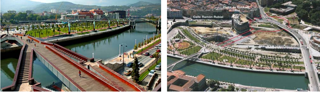
Şekil 5.143 : Pedro Arrupe yaya köprüsü (www.bilbaoria2000.org, 09.01.2010).
