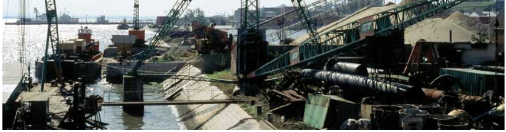
Şekil 4.42 : Lizbon doğu bölgesi - Expo 98'den önce sanayi alanı (Lisbon Expo-98 Projects, 1996).
