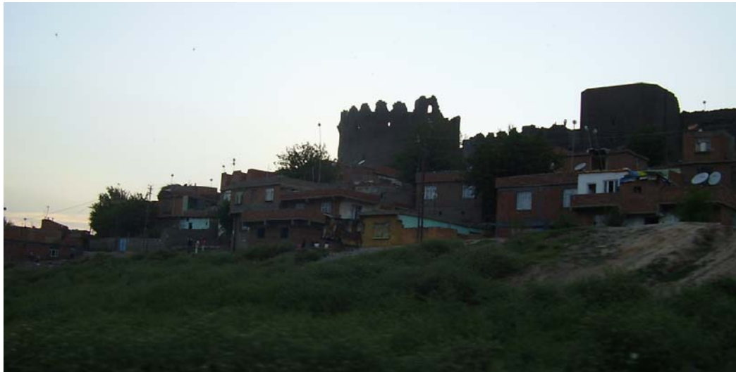
Şekil 6.12: Tarihi Diyarbakır Surları'na yapışık şekilde gelişen çarpık yapılaşma (Dizdar, 2009)
