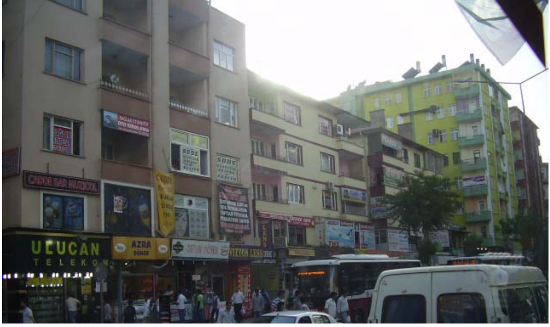
Şekil 6.20: Diyarbakır’da yeni yerleşim bölgesindeki bina cephelerinden bir görüntü (Dizdar, 2009)
