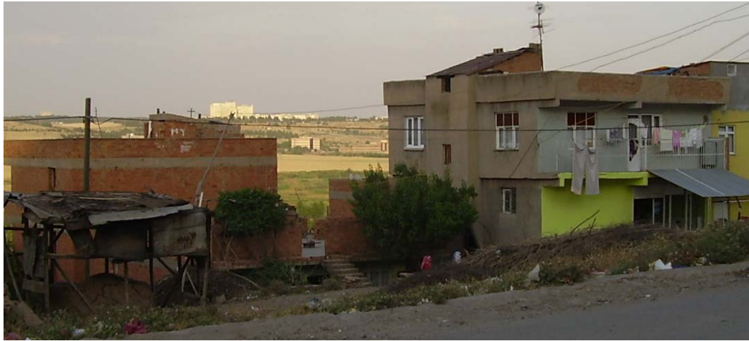
Şekil 5.23: Yeni yapılan tuğla dolgulu betonarme evlerden örnek (Dizdar, 2009)
