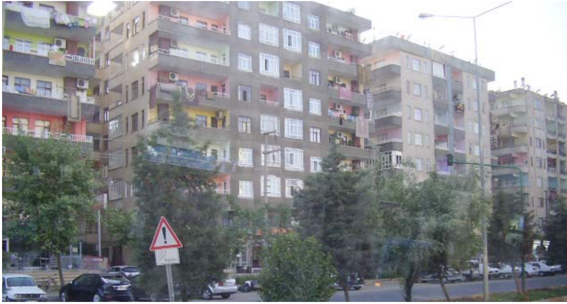
Şekil 6.19: Diyarbakır’da yeni yerleşim bölgesindeki sokaklardan bir görüntü (Dizdar, 2009)
