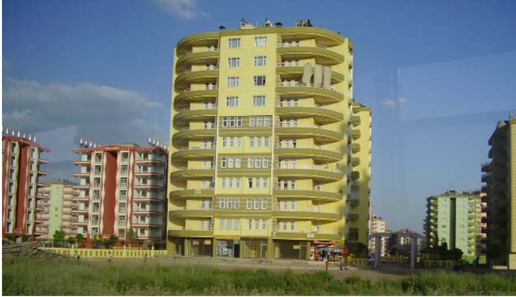
Şekil 6.22: Üst düzey gelir grubunun kullanımında olan konut bölgesinden genel bir görünüm (Dizdar, 2009)
