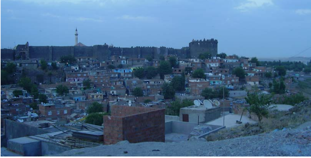
Şekil 6.13: Tarihi Diyarbakir Surları çevresinde gelişen çarpık yapılaşma (Dizdar, 2009)
