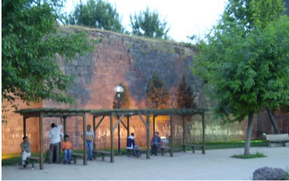
Şekil 6.8: Şehirdeki sınırlı kentsel boşluklarında kullanılan yetersiz güneş kontrol elemanları (Dizdar, 2009)
