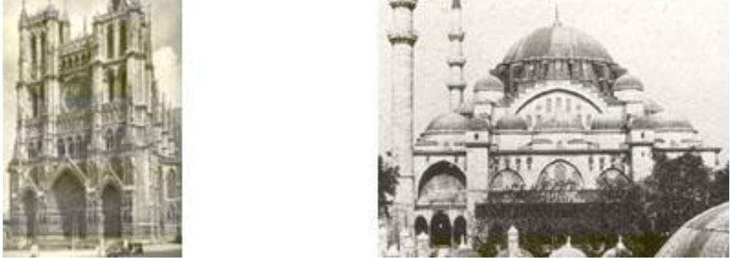
Resim 3.10. Gotik Katedral, Amiens Kenti (sol), Süleymaniye Camisi Batı Cephesi, İstanbul. (sağ). (kaynak: Hürlimann, M., Clemen P., Gotische Katedralen In Frankreich, Atlantis Verlag AG, Zurich, s. 97 (sol), Erzen, J. N., 1996. Mimar Sinan Estetik Bir Analiz, Sevki Vanli Mimarlık Vakfi Yayinlari, Ankara, s. 36 (sağ))
