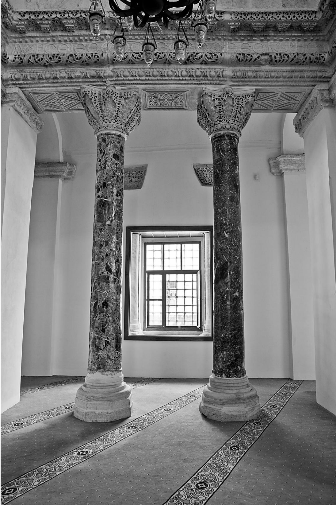
Şekil A.16 : Ana mekanın kuzey kenarı.
