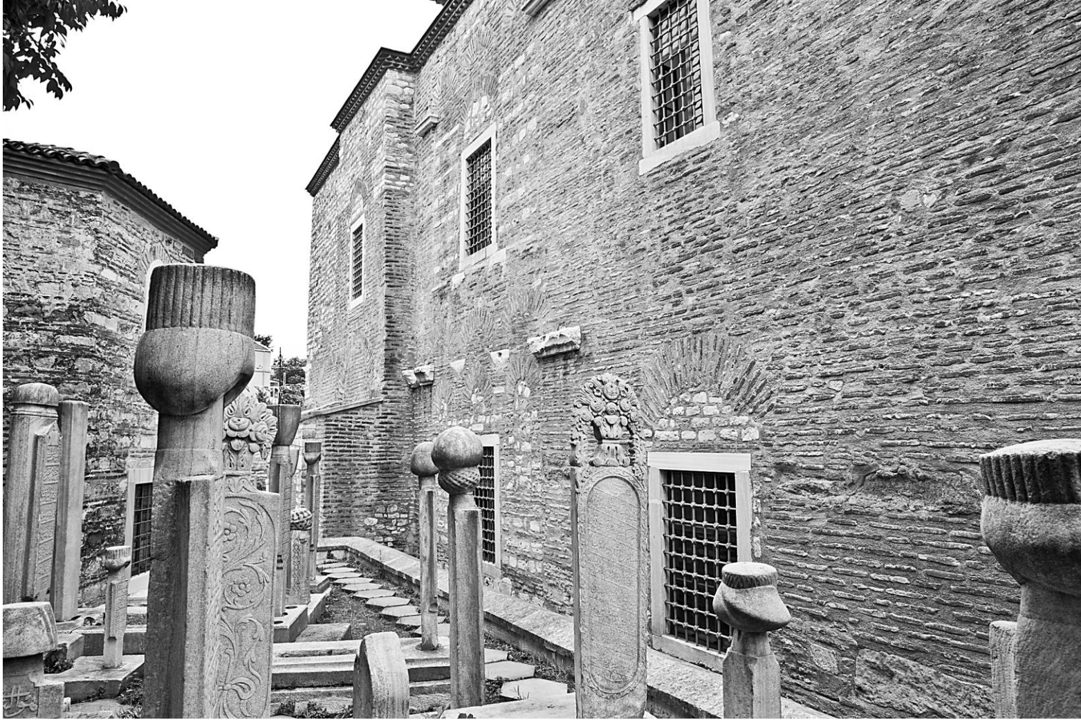
Şekil A.5 : Kuzey cephesi.
