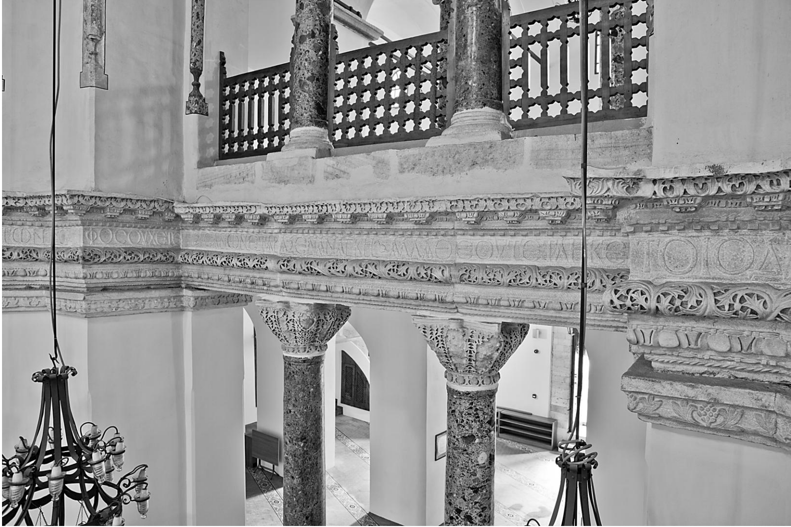
Şekil A.31 : Ana mekanın batı kenarında entablatur.
