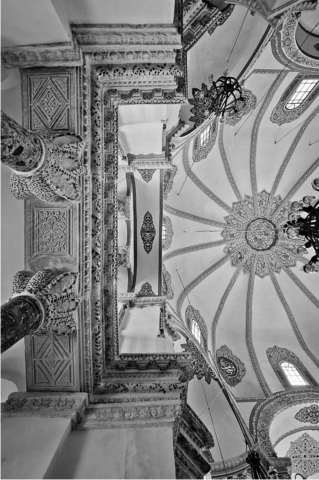
Şekil A.28 : Ana mekanın kuzey kenarı ve kubbe.
