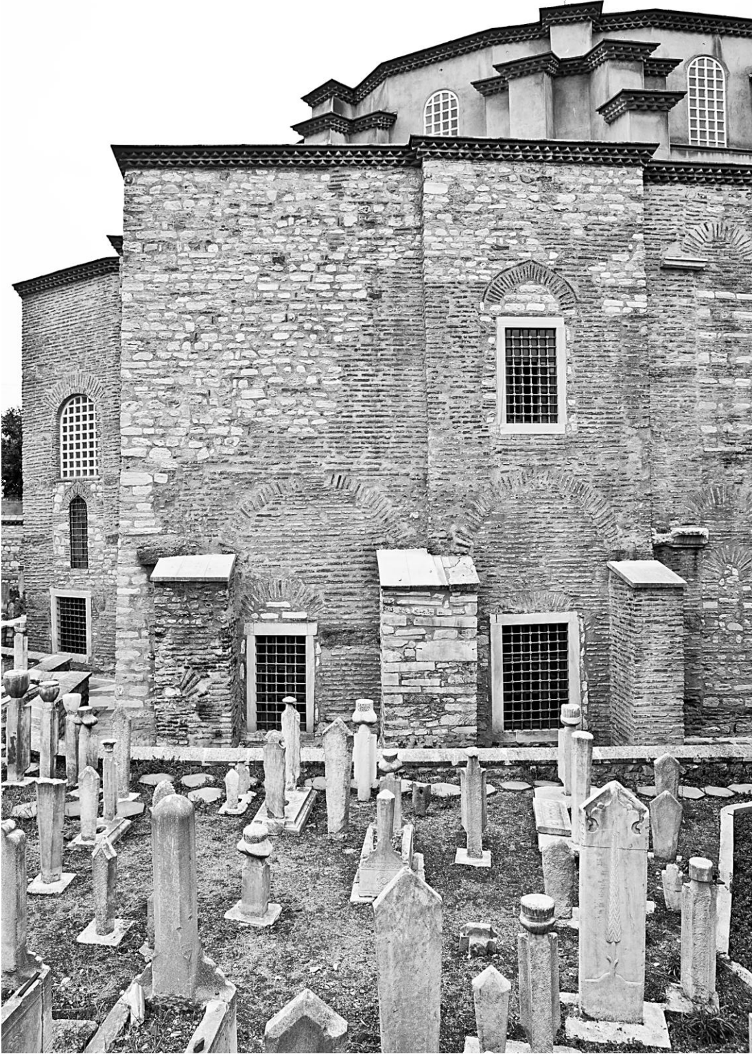
Şekil A.6 : Kuzey cephesi doğu bölümü.
