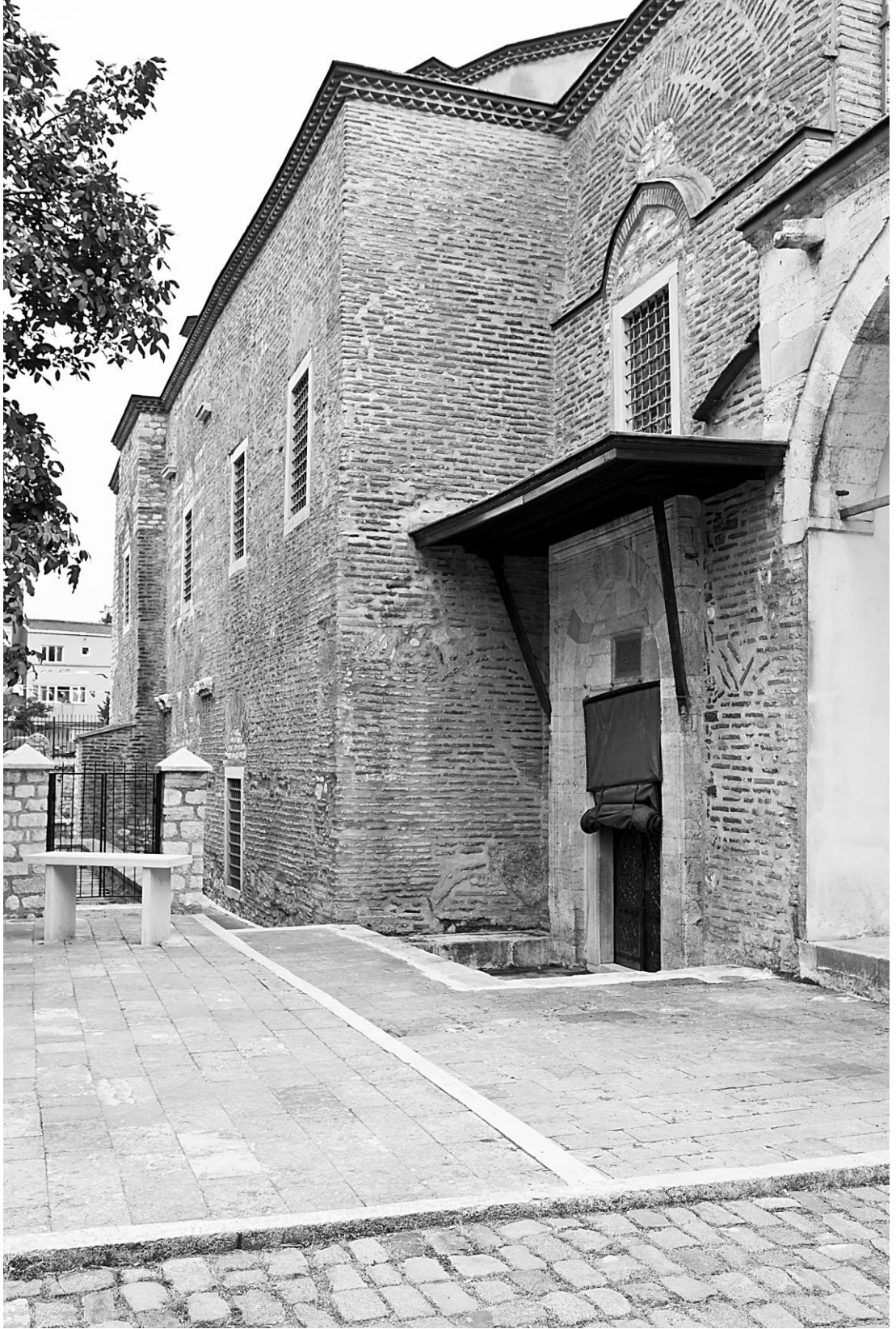
Şekil A.7 : Kuzeybatı köşesi.
