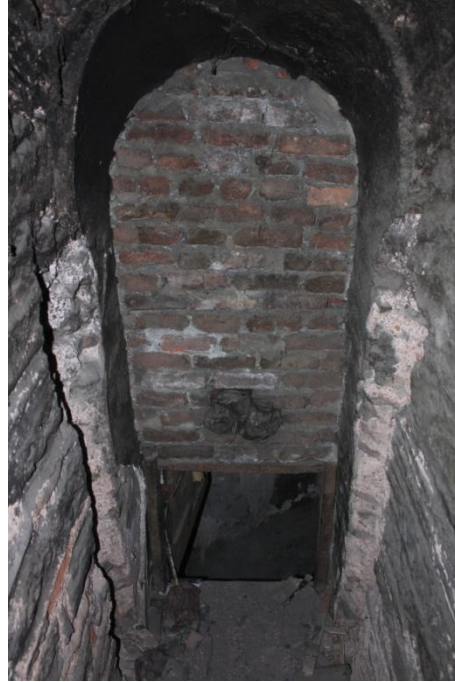
Şekil 2.42 : Duvar içindeki merdivenin başlangıcının iç taraftan görünüşü.
