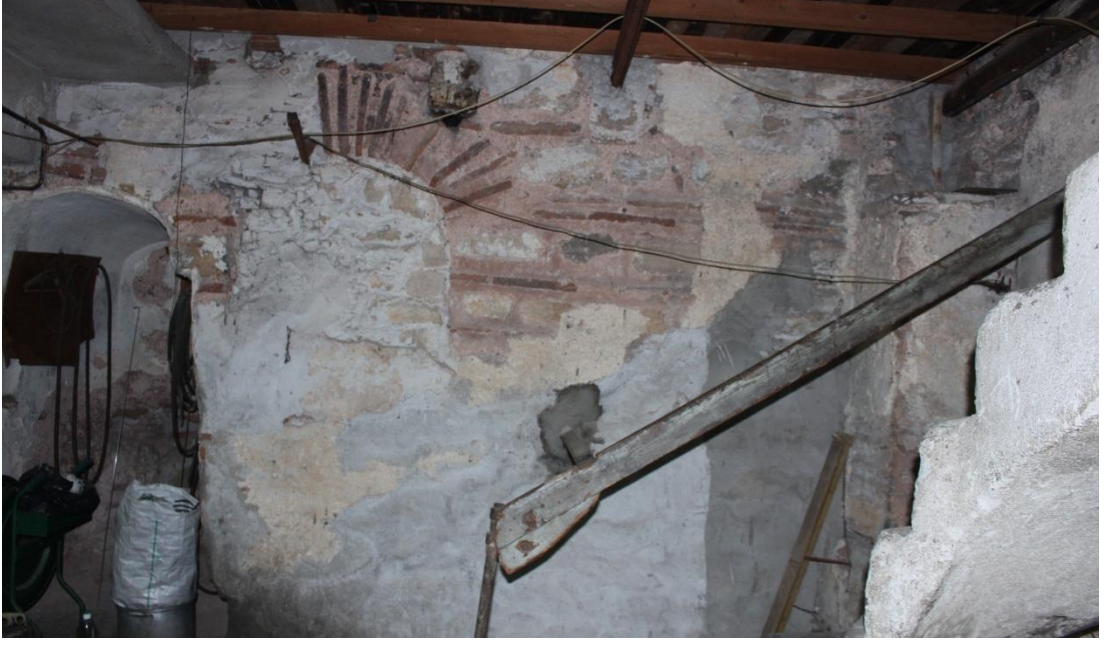
Şekil 2.30 : Güney duvarındaki doldurulmuş özgün pencerenin tuğla kemeri.
