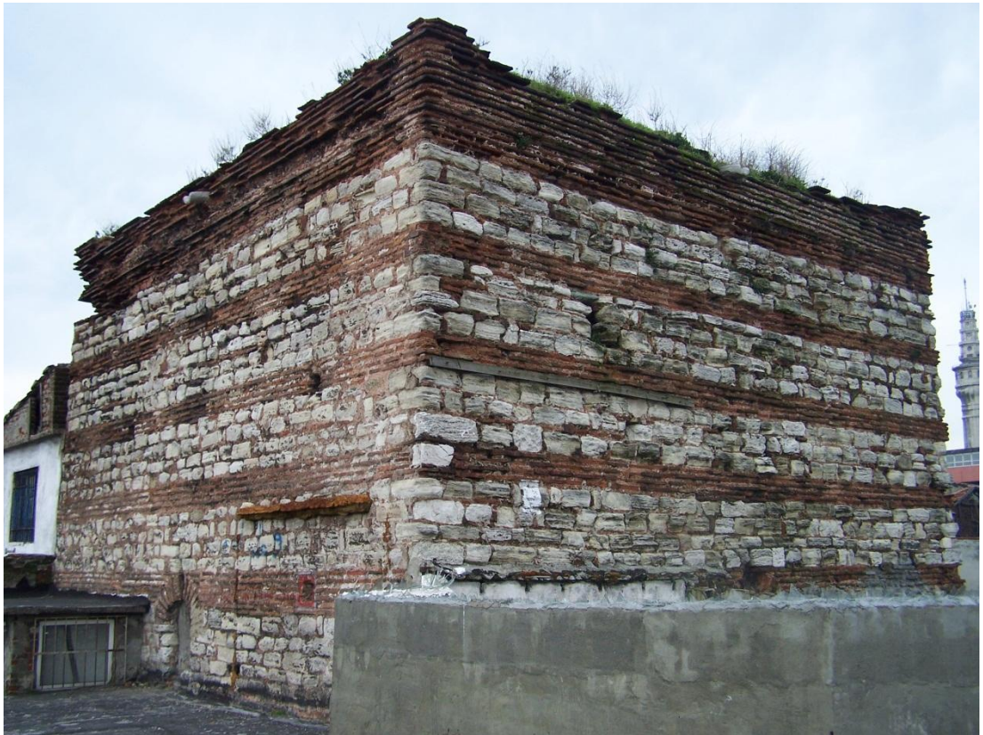
Şekil 2.15 : Doğu cephesi ve kuzey cephesi.
