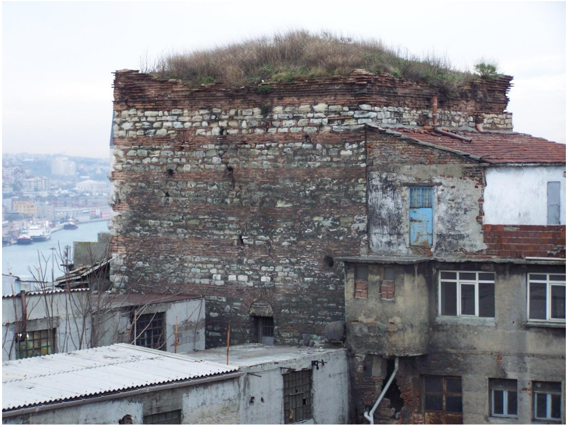
Şekil A.10 : İrene Kulesi batı cephesi
