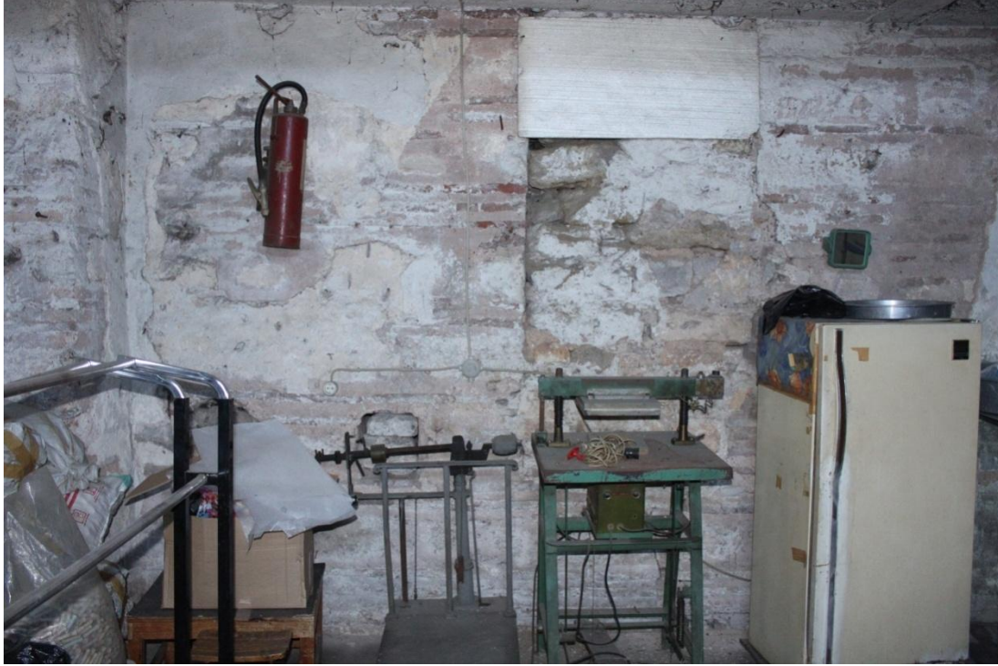
Şekil 2.7 : Giriş kat doğu duvarında bulunan doldurulmuş pencere açıklığı.
