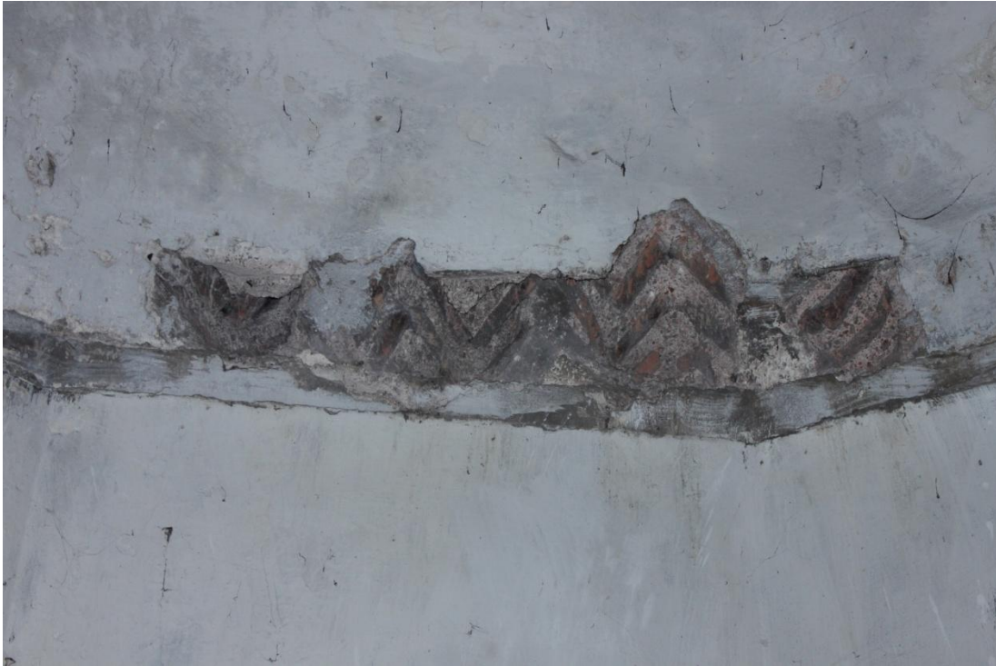
Şekil 2.25 : İrene Kulesi'nde bulunan tromp detayı.
