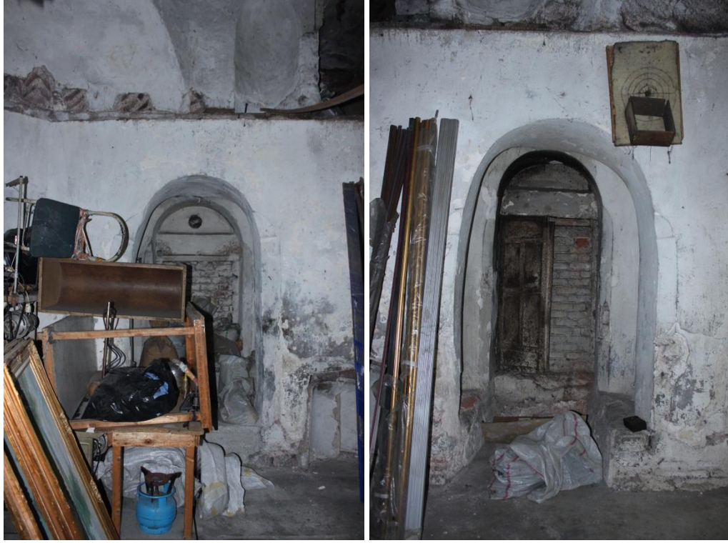
Şekil 2.27 : Doğu duvarı 7.21 ve 6.01 metre kotlarındaki özgün pencereler.
