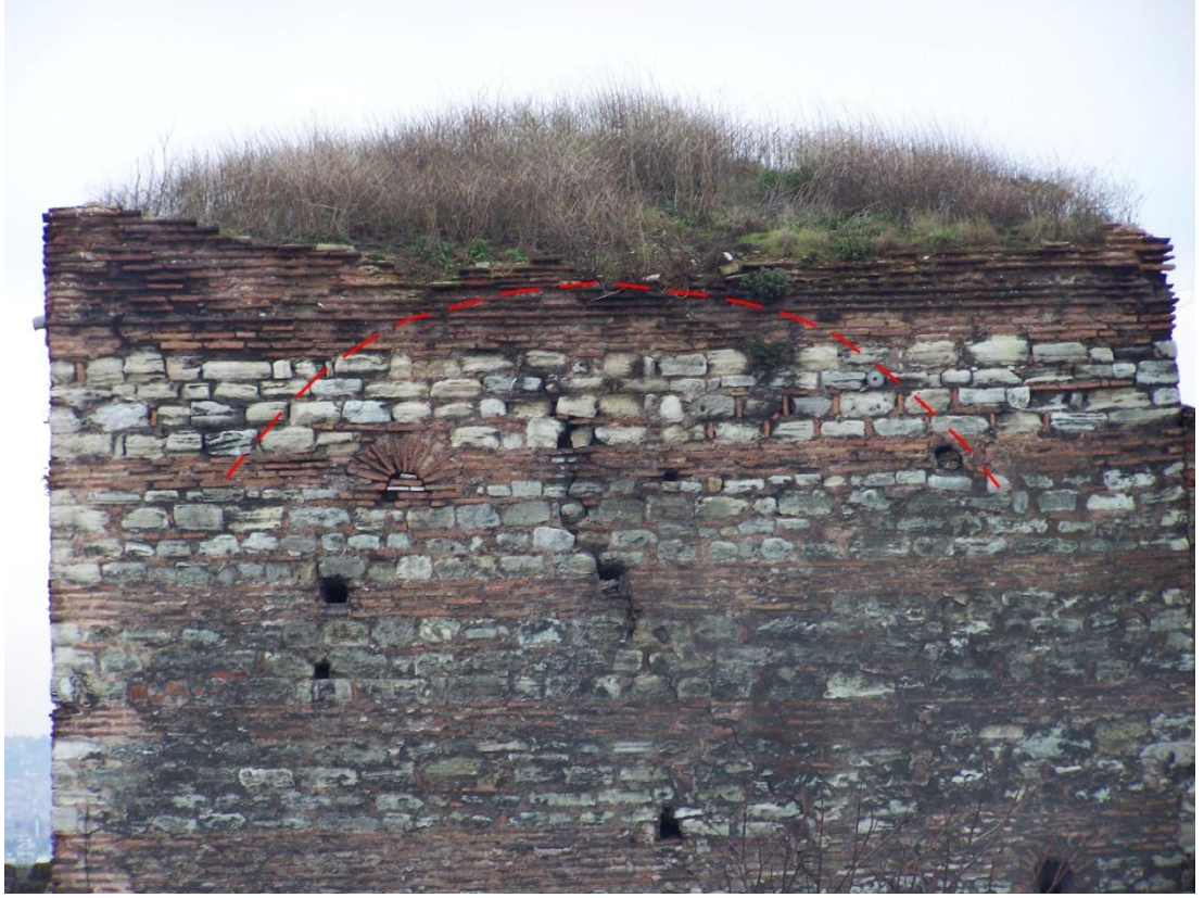
Şekil 4.9 : İrene Kulesi dilimli kubbesinin batı cephesinden görünüşü.
