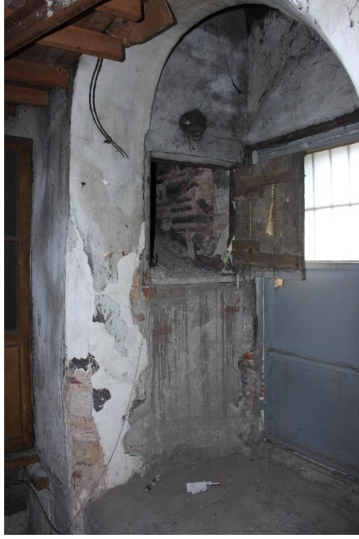
Şekil 2.39 : Duvar içindeki merdivenin başlangıcı ve özgün pencere.
