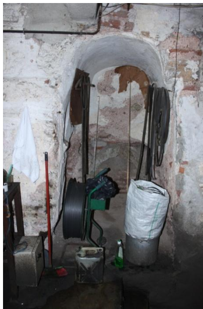
Şekil 2.36 : Güney duvarında 4.28 metre kotunda bulunan niş.
