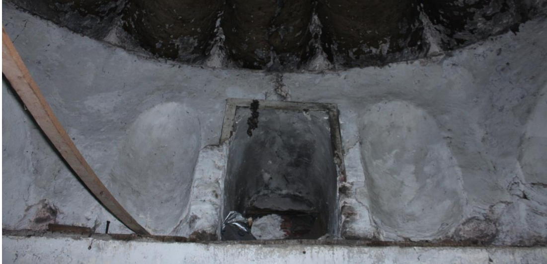
Şekil 2.28 : Doğu duvarında trompların hizasında bulunan özgün pencere.
