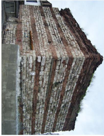
Irene Kulesi doğu ve kuzey cephesi 18 sıra tuğla-4 sıra taş-4 sıra tuğla-4 sıra taş-3/4 sıra taş-4 sıra tuğla-4 sıra taş-5 sıra tuğla-5 sıra taş
