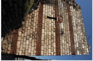
15 nolu kule doğu cephesi ve kuzey cephesi
