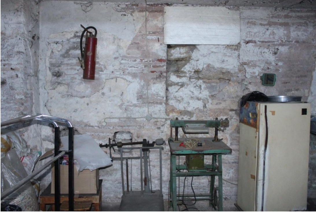
Şekil 2.26 : Doğu duvarının 1.94 kotundaki doldurulmuş özgün pencere .
