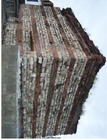
İrene Kulesi doğu ve kuzey cephesi 18 sıra tuğla-4 sıra taş-4 sıra tuğla-4 sıra taş-4 sıra tuğla-3/4 sıra taş-4 sıra tuğla-4 sıra taş-5 sıra tuğla-5 sıra taş
