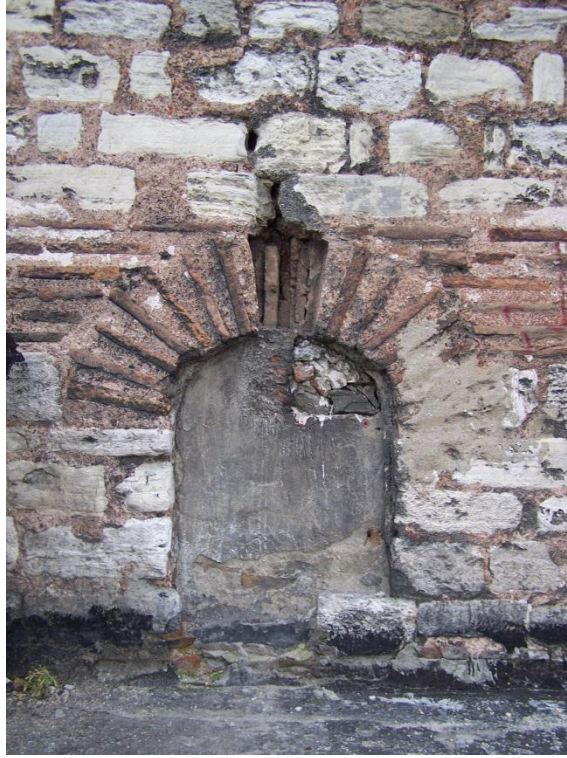
Şekil 2.16 : Doğu cephesinde 9.87 kotunda başlayan pencere.
