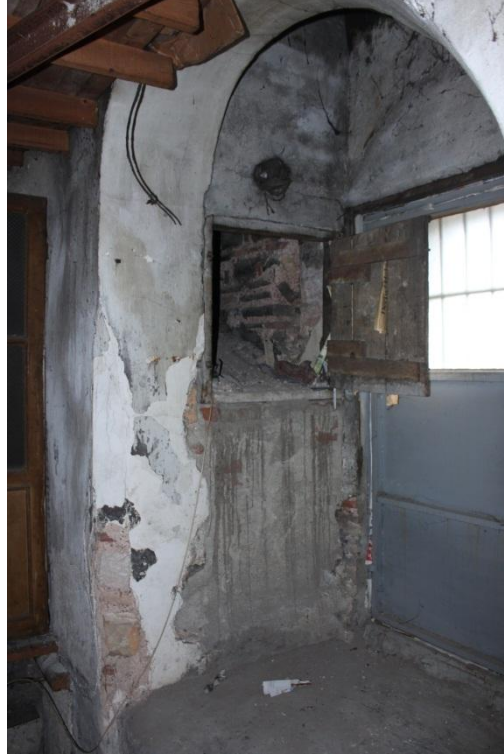
Şekil 2.9 : İkinci kat batı cephesinde merdivenin olduğu bölmenin girişi.
