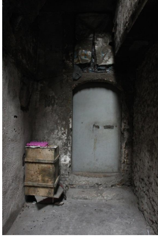
Şekil 2.21 : Batı cephesinde bulunan giriş.
