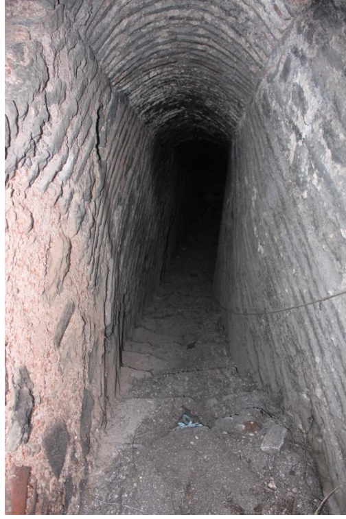
Şekil 2.41 : Güney duvarı boyunca duvar içindeki merdivenin görünüşü.
