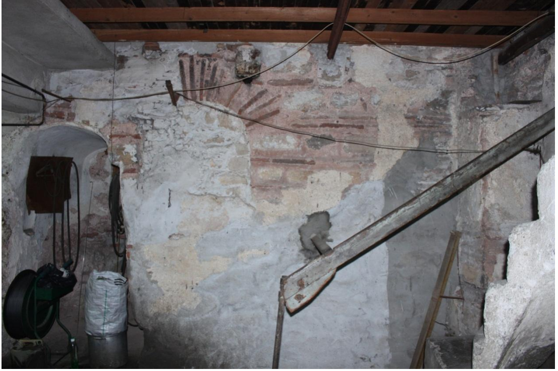
Şekil 2.8 : Birinci kat güney duvarında bulunan doldurulmuş kemerli pencere.
