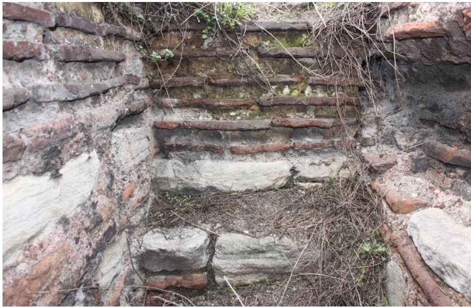
Şekil 2.40 : Duvar içindeki merdivenin batı duvarı tarafında kesildiğı kısım.
