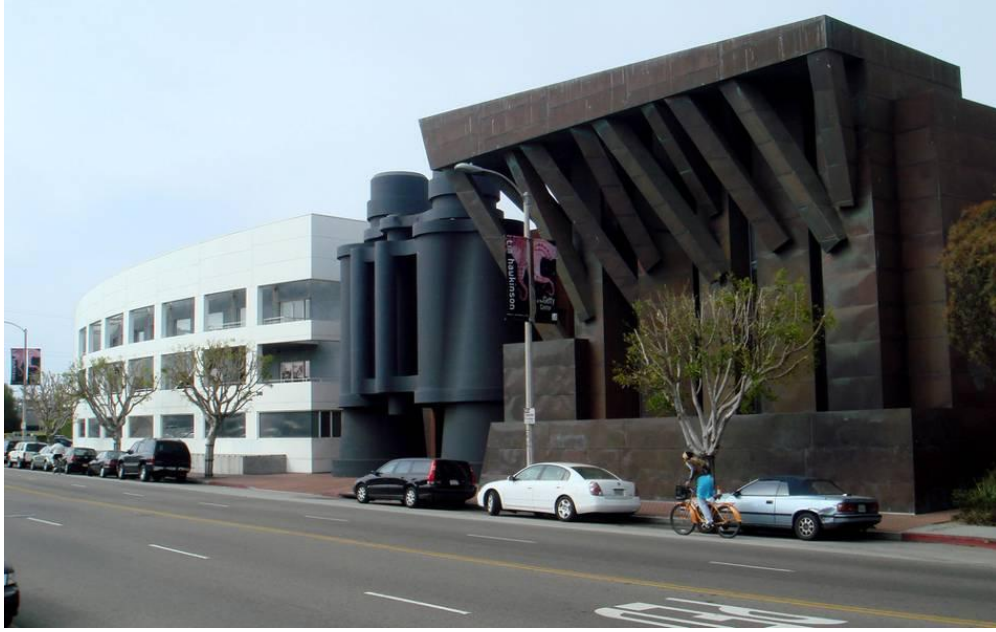
Şekil 4.11 : Chait Day Binası, Yol Görünüşü (Url-23).
