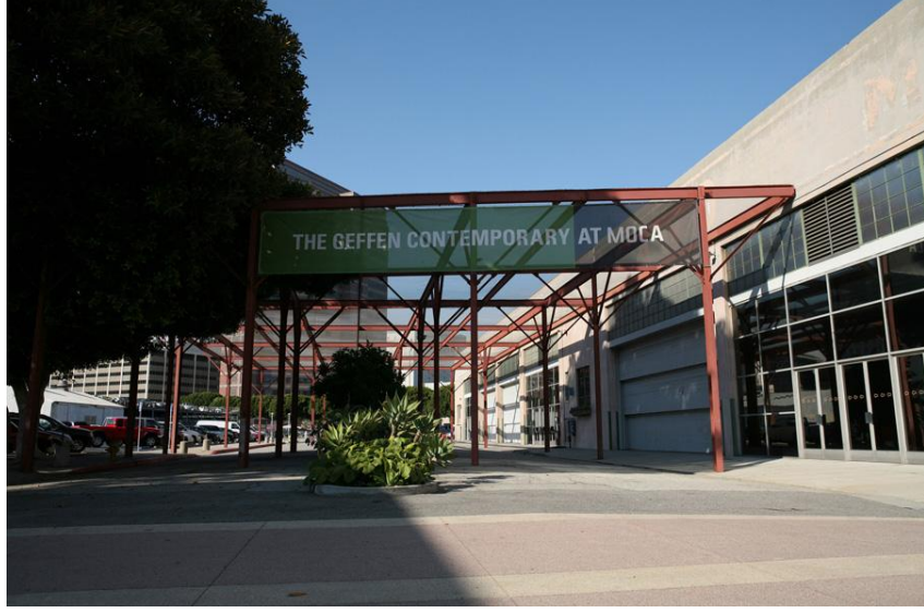
Şekil 4.4 : Geffen Contemporary, Giriş Kısım ve Saçak (Url-19).
