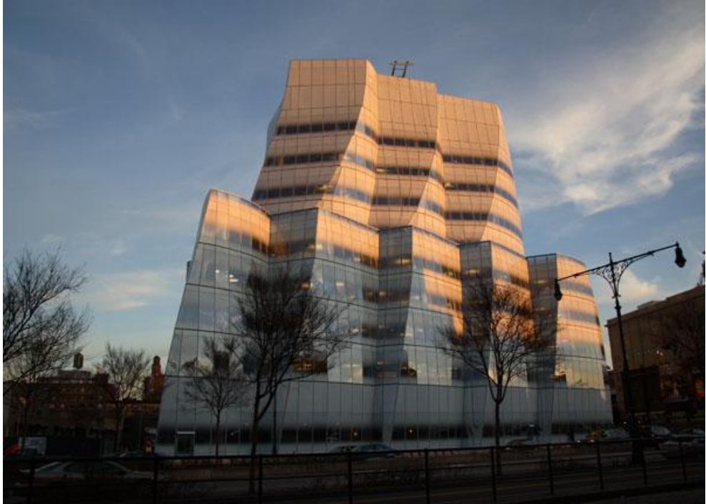
řekil 5.96 : IAC Binası Gn Batımı Grnm (Url-68).
