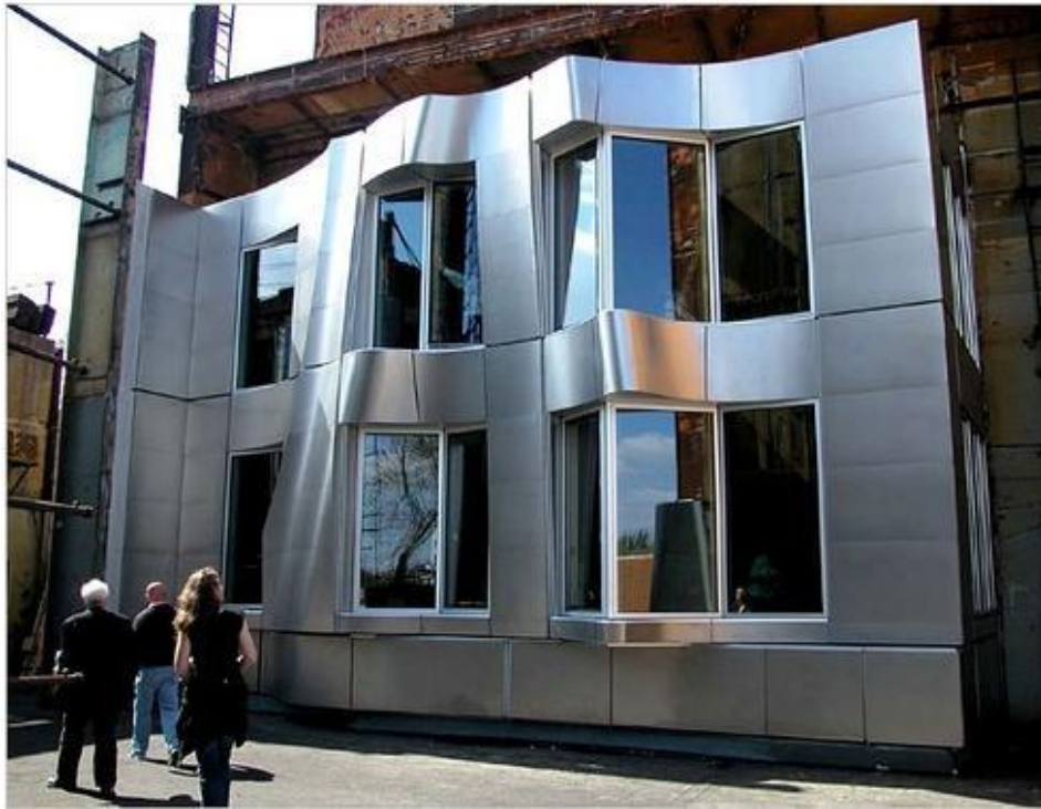
Şekil 5.111 : Beekman Kulesi, Cephe Paneli Örneği (Url-81).
