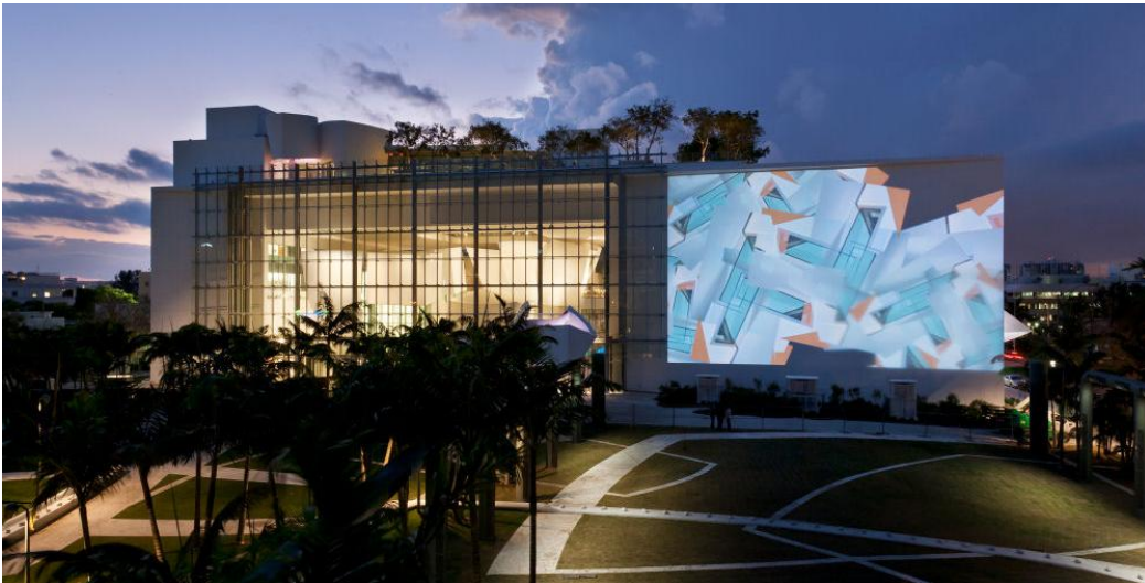
Şekil 5.119 : Cam Perde Duvar ve LED Ekran (Url-85).
