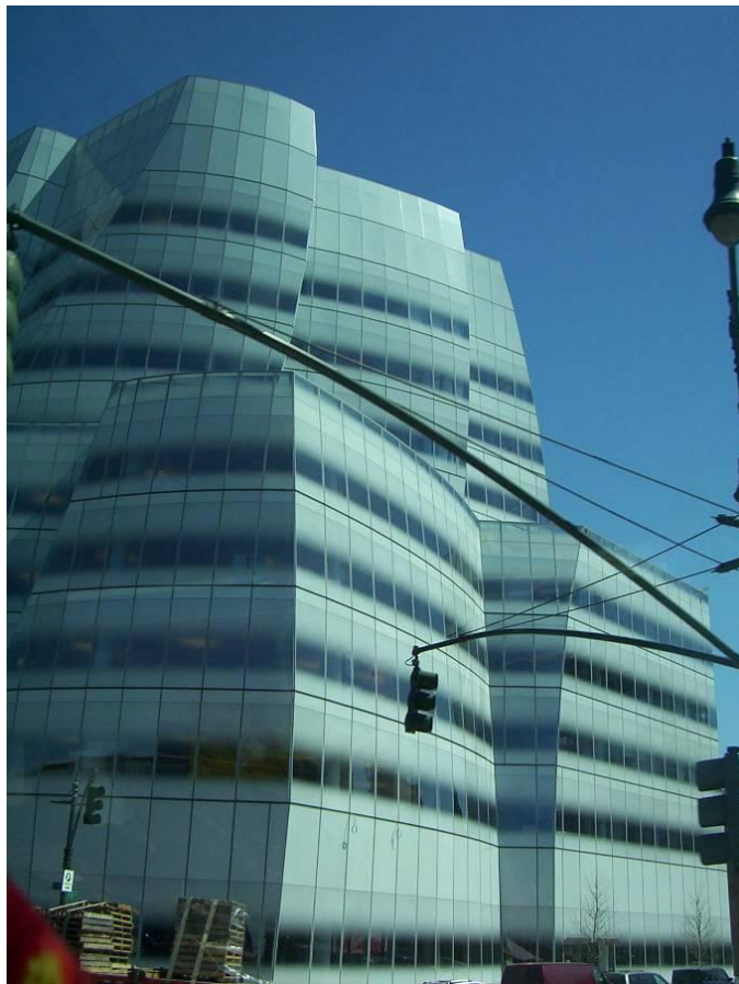
Şekil 5.92 : IAC Binası Ana Yol Görünümü (Url-63).
