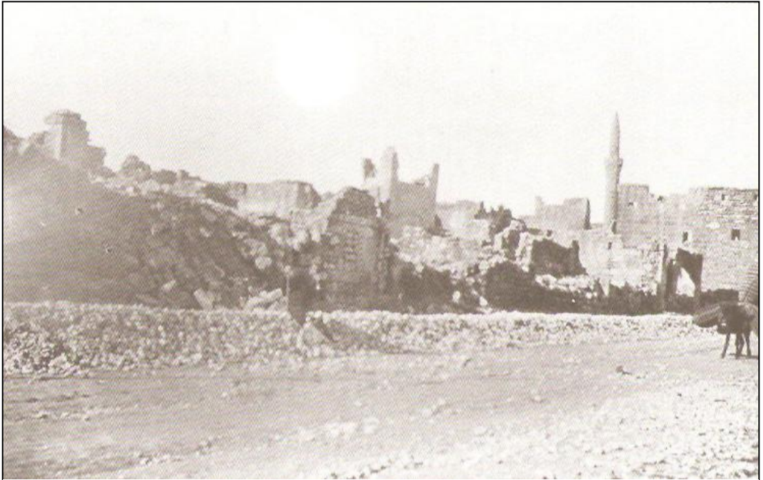
Şekil D.10 : Gaziantep Kalesi'nin dış surlarının yıkıntıları (Uğurluer, 2008).
