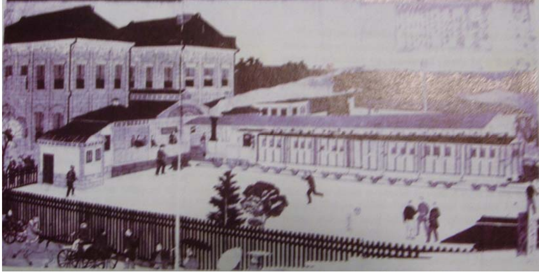
Şekil 2. 35 : Shimbashi Tren İstasyonu, Tokyo. (Abe, 1954)
