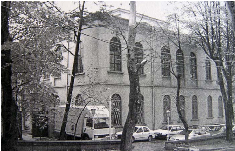
Şekil 3. 11 : Hazine-i Evrak Binası (Çelik, 2008)
