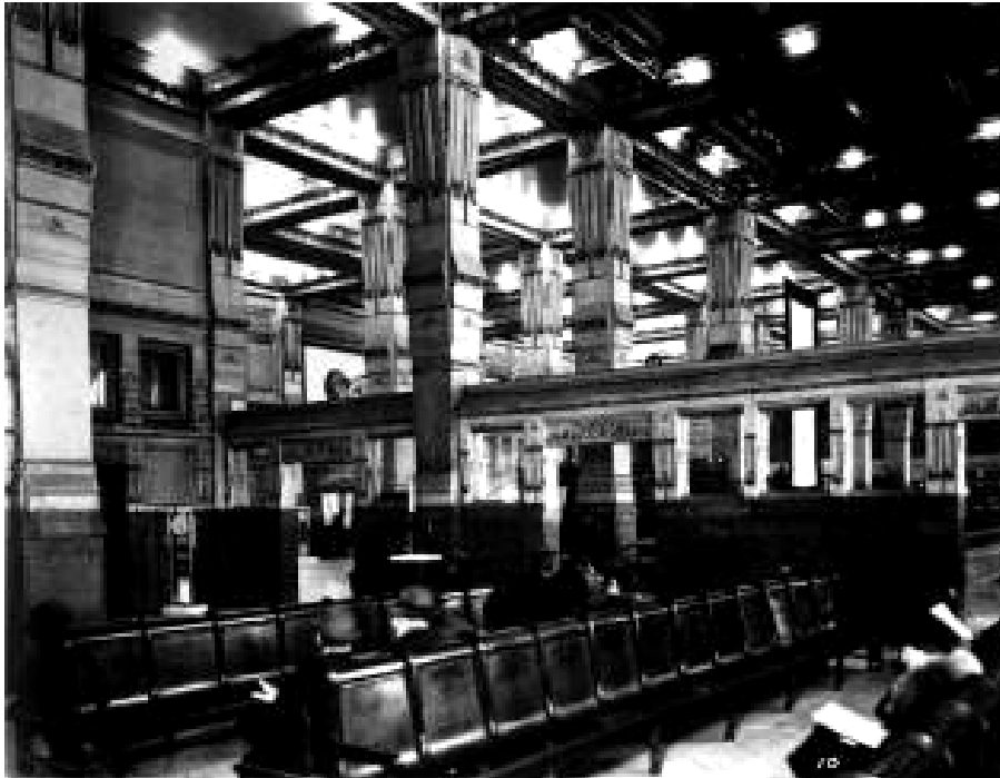
Şekil 2.81 : Broad Street Station, Frank Furness, Pennsylvania, 1881. İç mekandan bir görünüm. İnşa edildiđi dönemde dünyanın en büyük yolcu terminali olan yapı, 1923 yılında çıkan yangında büyük zarar görmüş, 1950'lere gelindiğinde yıkılmıştır. [128]
