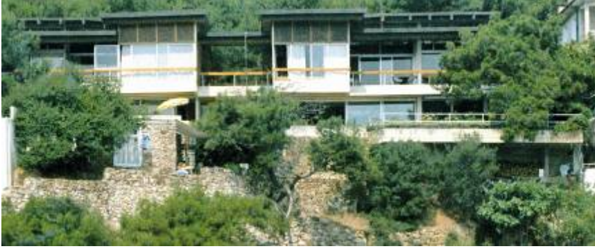
Şekil 2.69 : Kamhi-Grünberg İkiz Villası. Villaya denizden bakış. Eğimli bir arazide konumlanan yapı, çevresindeki yeşil alanın ortasında cam bir kütle olarak öne çıkıyor. [114]
