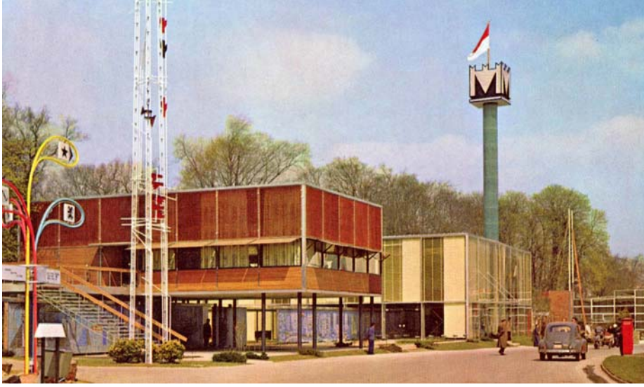
Şekil 2.6 : Uluslararası Brüksel Sergisi Türkiye Pavyonu; Utarit İzgi, Muhlis Türkmen, Hamdi Şensoy ve İlhan Türegün; Brüksel, 1958. [2]
