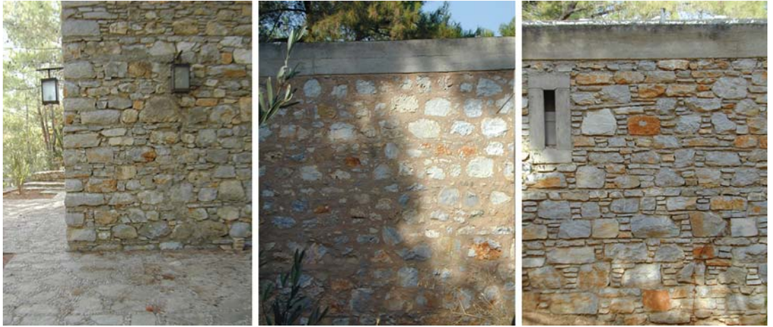
Şekil 4.10: Demir Evleri, Taş duvar farklılıkları(U. Demirgüç, 2006)
