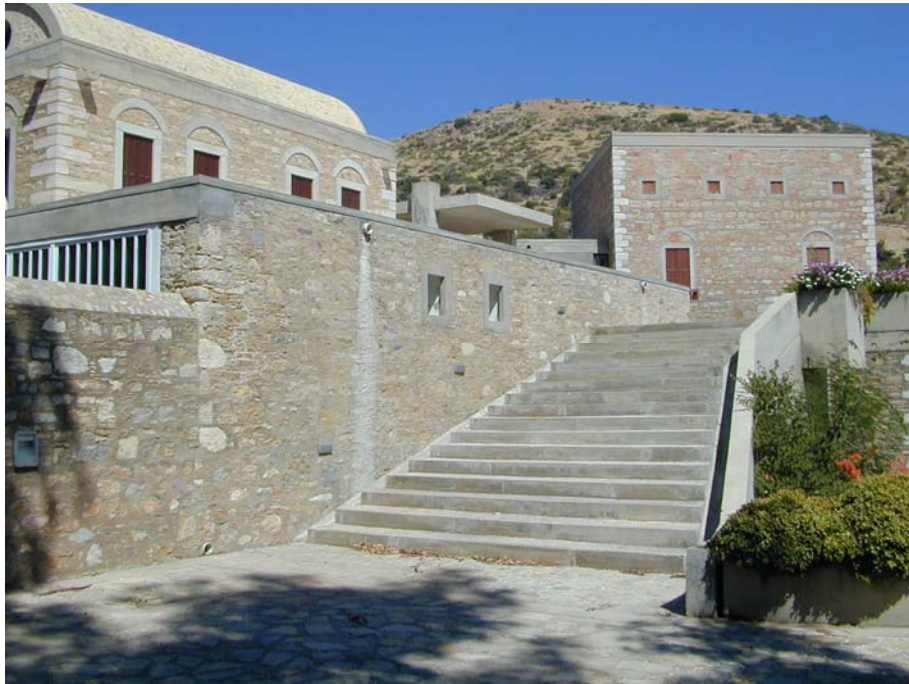
Şekil 4.26: Su Altı Arkeoloji Araştırma Enstitüsü, Giriş Merdivenleri (U.Demirgüç, 2006)
