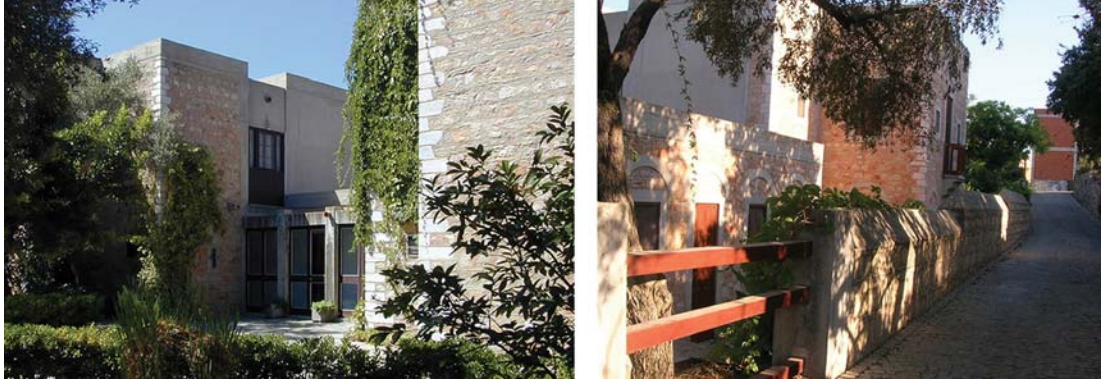
Şekil 4.27: Konaklama biriminin avludan ve sokaktan görünüşü
