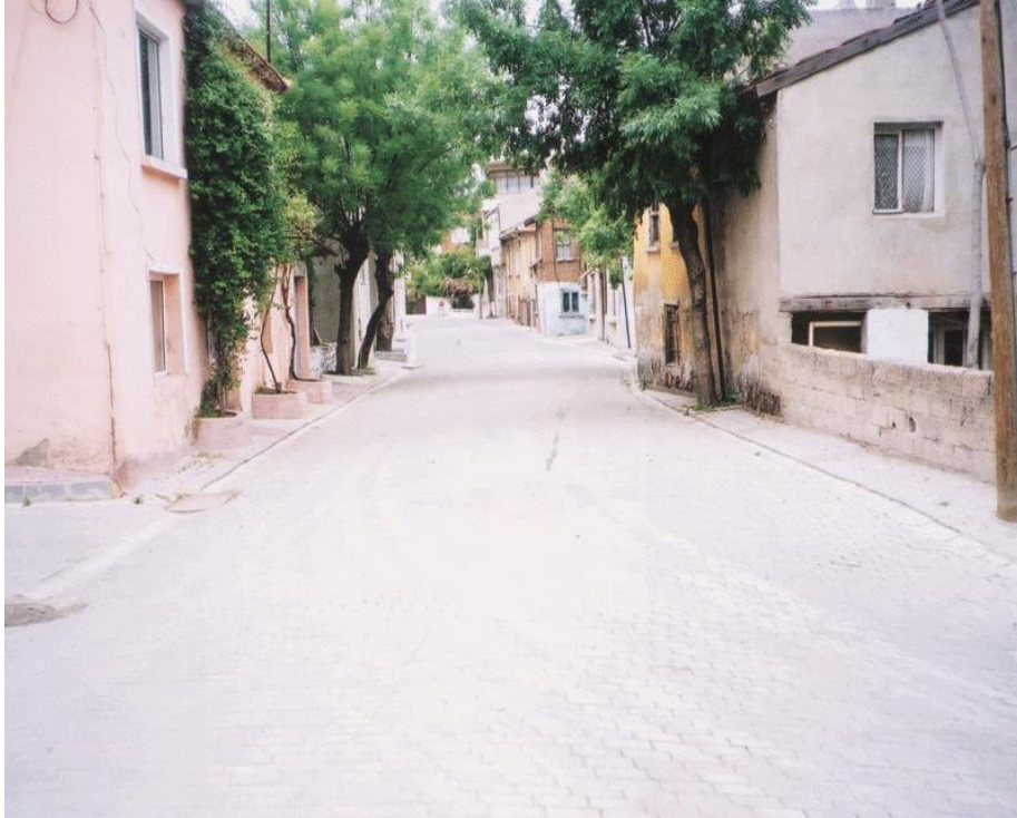
Şekil:5.3. Çatalca İlçesi – Kale Sokak
