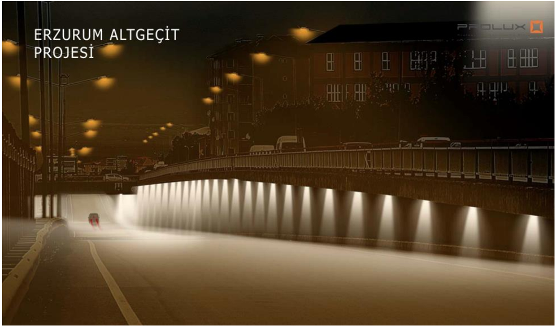
Şekil 5.3 : Erzurum altgeçit projesi, aydınlatma simülasyon çalışması. (Kaynak: Prolux Arşivi, 2013)
