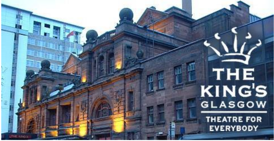
Şekil 4.23 : Kings Theatre, gece görünümü, Glasgow. (Kaynak: http://www.ffe-uk.com/venue.php?venueid=77 )
