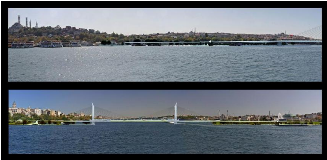
Şekil 4.17 : Haliç Metro Geçiş Köprüsü, İ.B.B.
