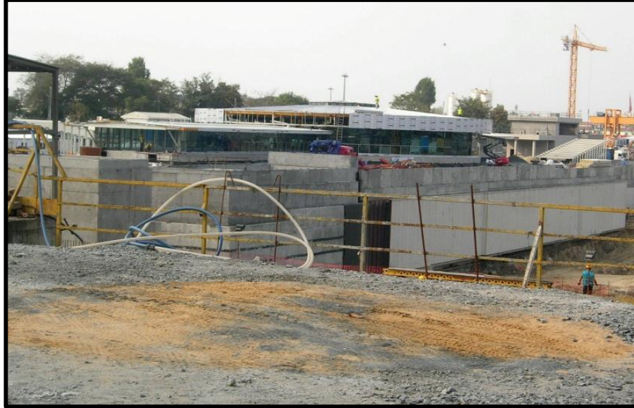
Şekil 5.42 : Marmaray Yenikapı İstasyonu [97]
