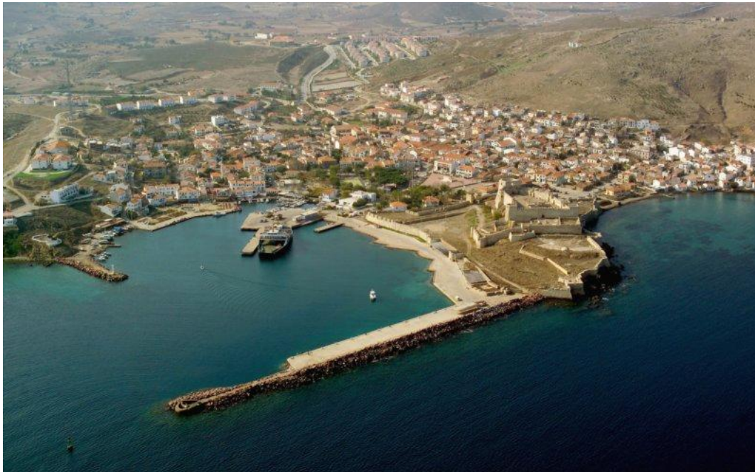
Şekil 3.23 : Bozcaada yerleşimine ait hava fotoğrafı (Url-18).
