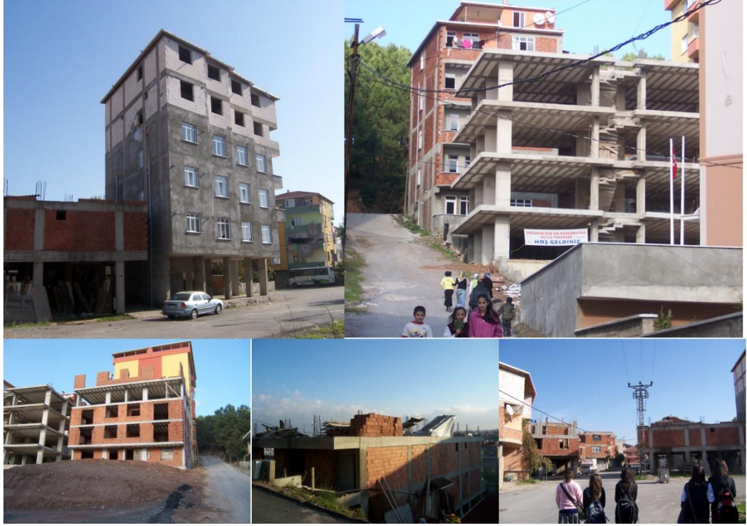
Şekil 5.19 : Sultanbeyli’de inşa halindeki yapı örnekleri.
