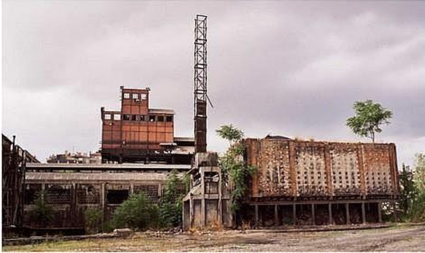
Şekil 3.16 : Hasanpaşa Gazhanesi'nin mevcut durumu (Url-29, 2010)
