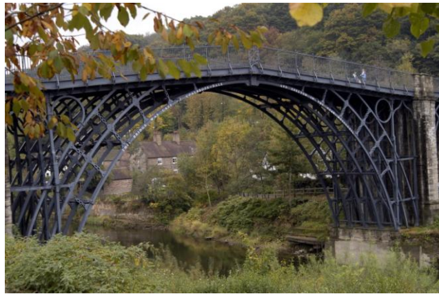
Şekil 3.2 : İngiltere'deki Iron Bridge Köprüsü (Url-14, 2011)
