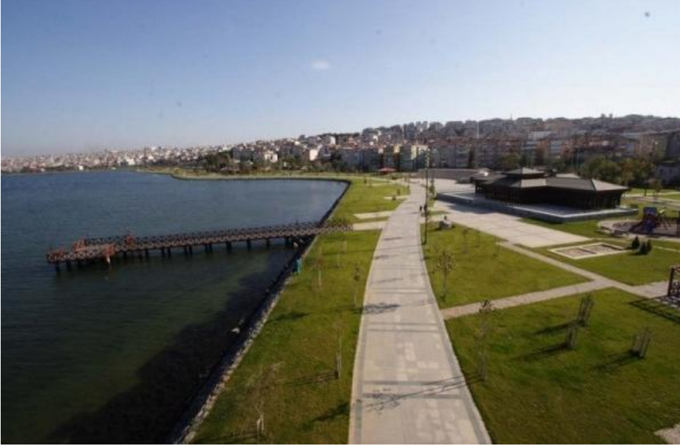
Küçükçekmece Sahil Alanından Görünüm
