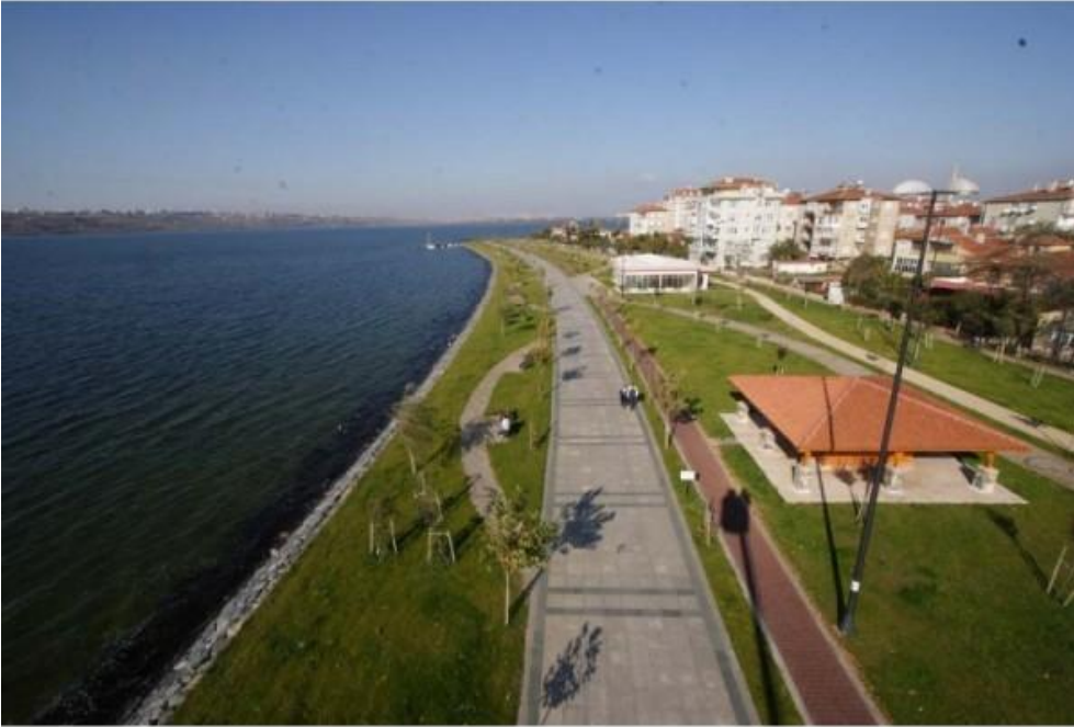
Küçükçekmece Sahil Alanından Görünüm
