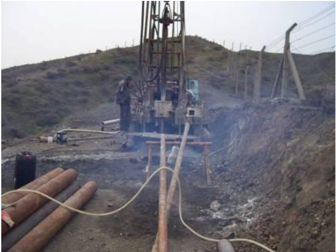
Şekil 4.11 : K.S.İ. Üniversitesi Kampüs tilt istasyonu sondaj çalışmaları.
