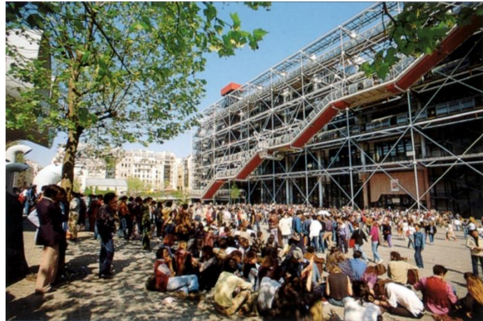
Şekil 5.5 : Centre Pompidou ön cephesi, Rogers Stirk Harbour + Partners, Url-3
