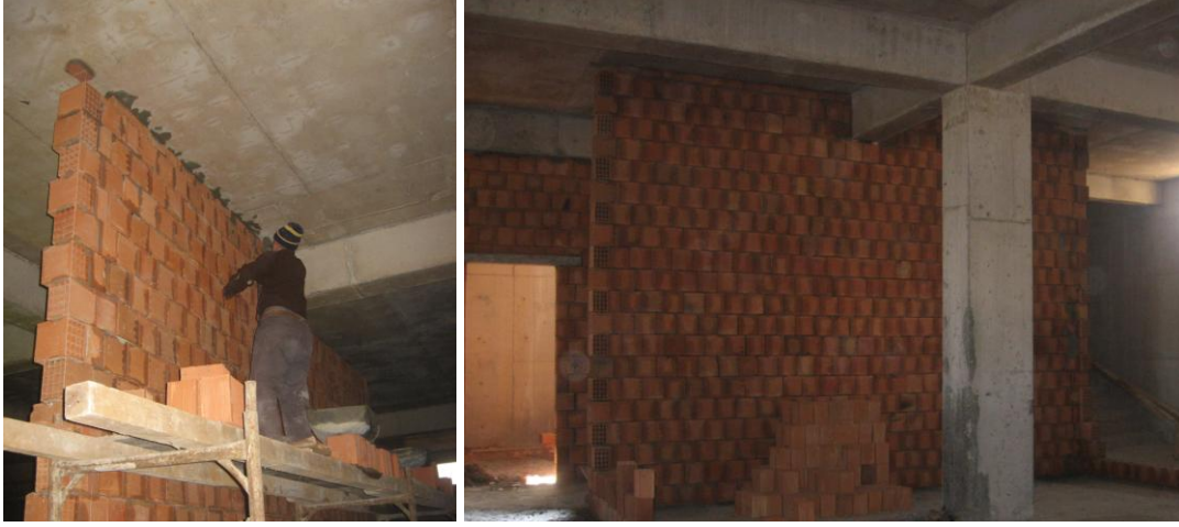
Şekil 5.15: Duvarcı ustası 2 tarafından örülen tuğla duvar.
