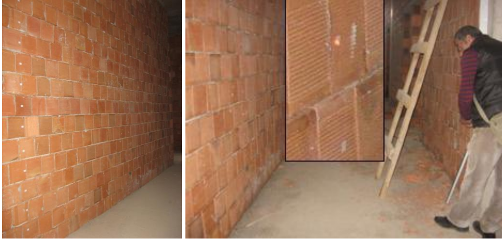
Şekil 5.16: (a) Duvar yüzeyi üzerinde belirlenen üç düşey hat. (b) Uzaklık ölçümünün yapılması.
