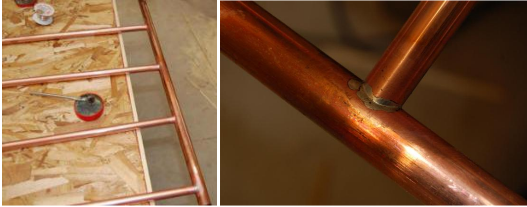
Şekil 2.22: Bakır boru lehimleme uygulaması [22].
