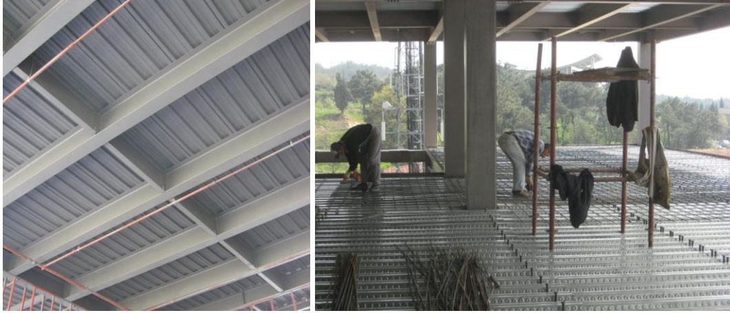
Şekil 2.4: Çelik kiriş üzeri trapez levha uygulaması.
