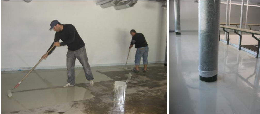
Şekil 2.13: Epoksi döşeme kaplama uygulaması.
