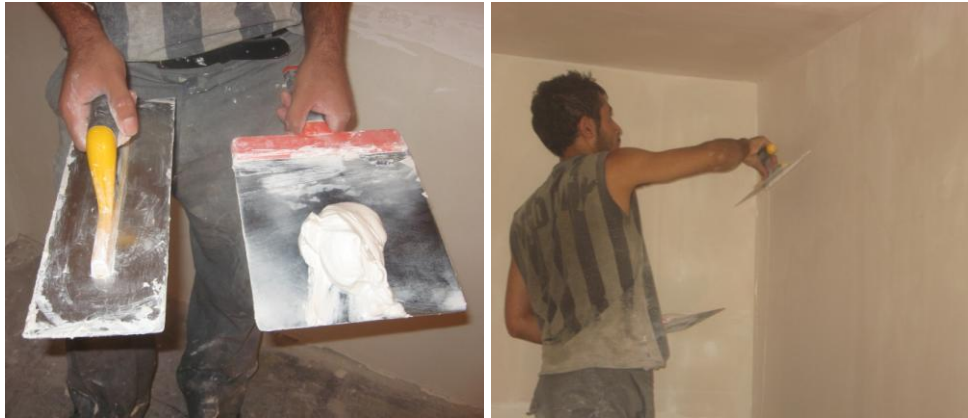
Şekil 2.17: Alçı sıvanın mala ile duvar yüzeyine sürülmesi.
