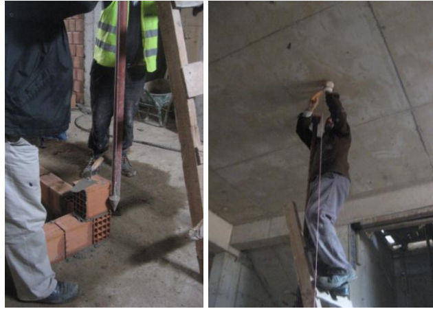
Şekil 5.13: Duvar başlangıç noktasında düşey ipin şakulüne alınması.
