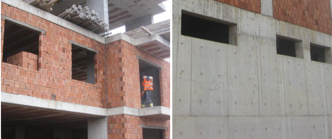
Şekil 2.8: Örme sistem ve dökme sistem duvarda boşluk oluşturma.
