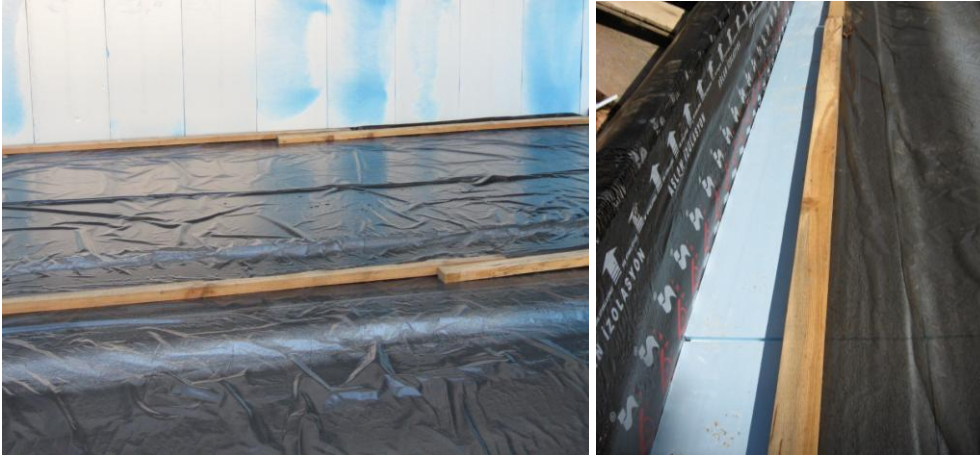
Şekil 2.11: Polietilen folyo uygulaması.
