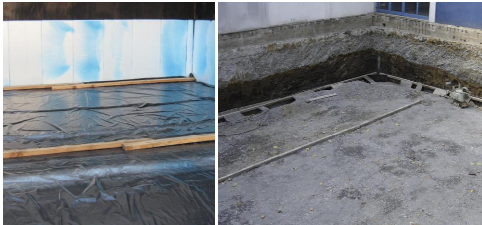
Şekil 2.19: (a) Polietilen su yalıtım örtüsünün yüzeye serbest serilmesi. (b) Çakılın sıkıştırılmış zemin üzerine serbest dökülmesi.
