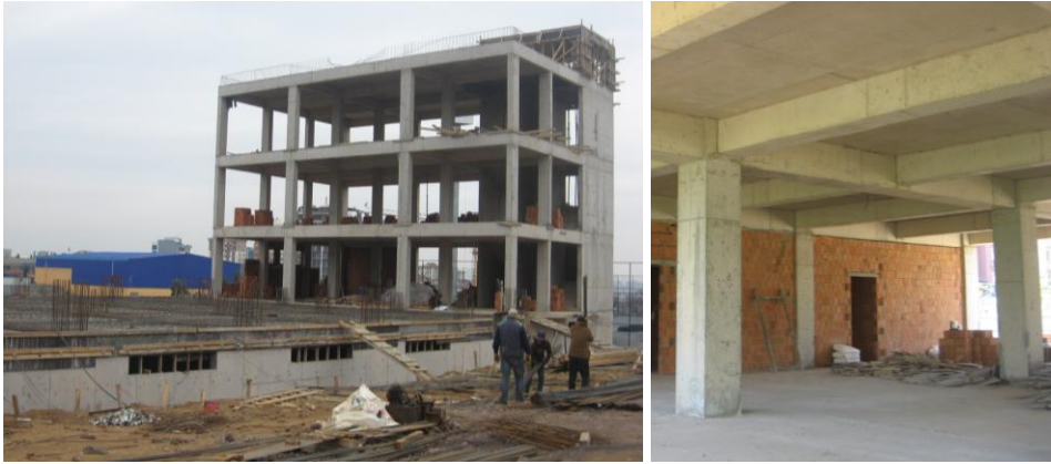
Şekil 5.1: Uygulamanın gerçekleştiği spor kompleks binası şantiyesi.
