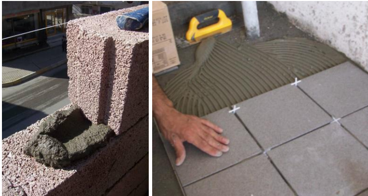
Şekil 2.20: Harç ile bims blok ve seramik karo uygulaması [2].
