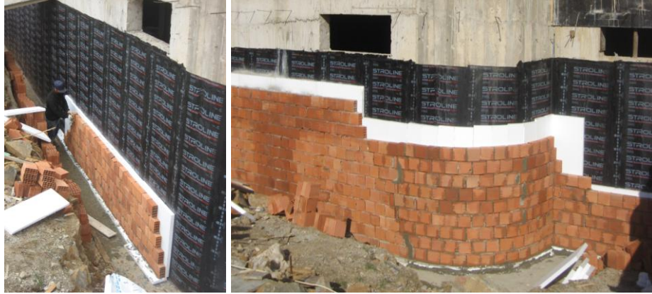
Şekil 2.9: EPS levhaların serbest dizilerek uygulanması.
