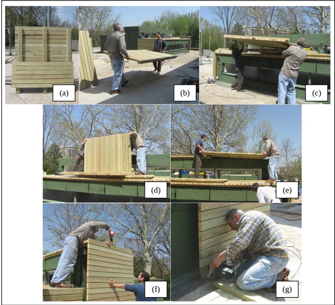
Şekil 3.2: Ahşap pano cephe ve çatı kaplama uygulaması.
