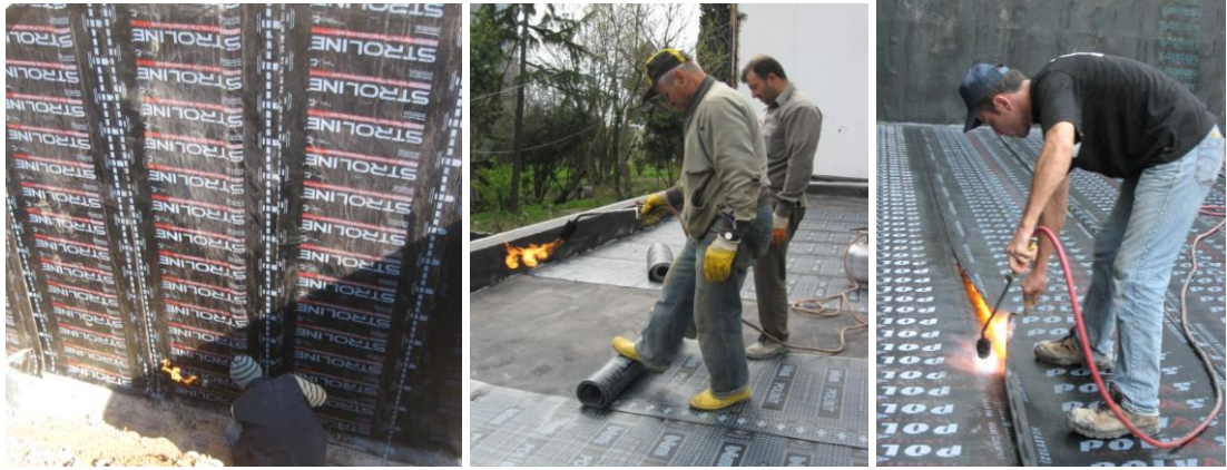
Şekil 2.24: Duvar, çatı ve zemine oturan döşemede şalümo alevi uygulaması.
