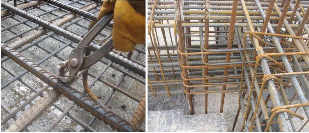
Şekil 2.25: Donatı demirlerinin tel ile birleşimi.
