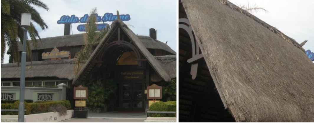
Şekil 2.12: Saz çatı kaplaması.
