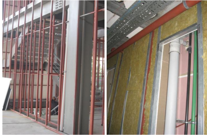
Şekil 2.3: Alüminyum kutu profil ve hafif çelik C profil iskelet sistem iç bölme duvar uygulaması.
