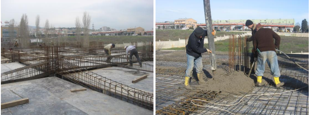
Şekil 2.6: (a) Kiriş donatılarının yerleştirilmesi. (b) Betonunun dökülmesi.
