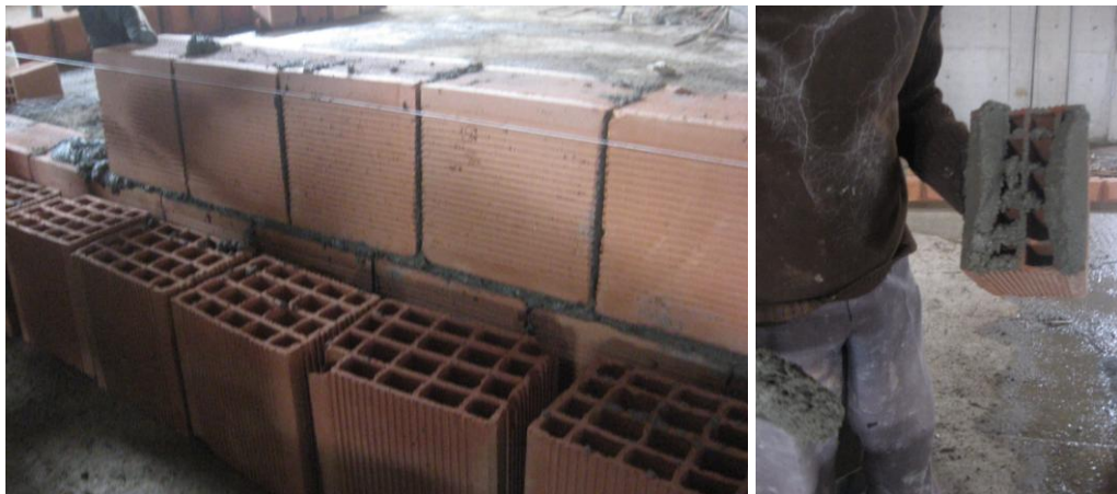
Şekil 5.14: (a) Her tuğla sırasında yatay ip hizalaması. (b) Harcın tuğla düşey yüzeyinin iki kenarına uygulanması.
