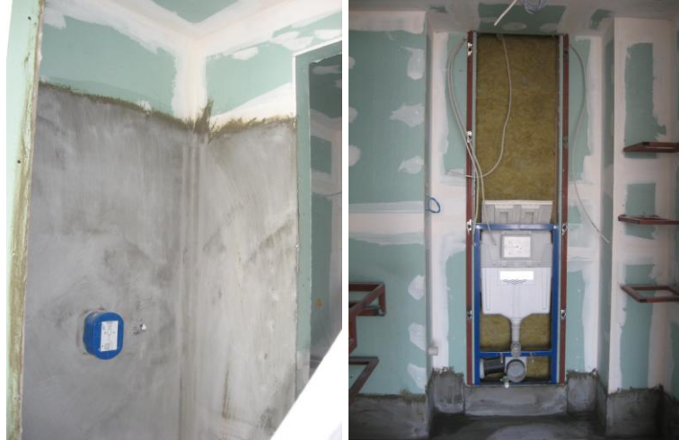
Şekil 2.10: Duvar ve döşeme yüzeyinde sürülerek uygulanan su yalıtımı.
