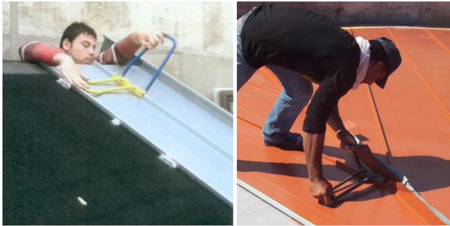
Şekil 2.21: Kenetleme ile metal çatı kaplama levha uygulaması [2].
