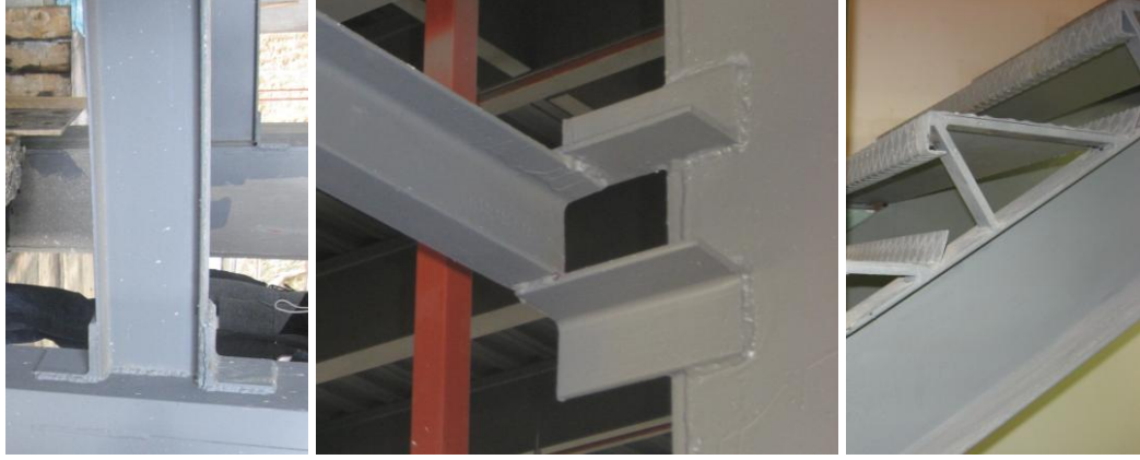
Şekil 2.23: Kaynaklı çelik profil birleşimleri.
