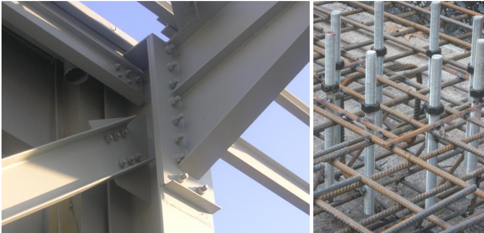
Şekil 2.29: Civata / somun ile kolon - kiriş birleşimi ve ankraj bulonu ile radyetemel - kolon birleşimi.
