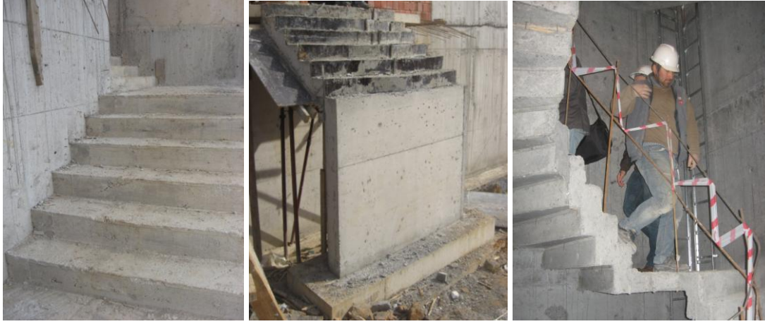
Şekil 2.7: Betonarme merdiven uygulaması.
