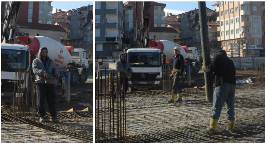
Şekil 2.32: Beton pompa operatörü kontrolünde beton dökümü.
