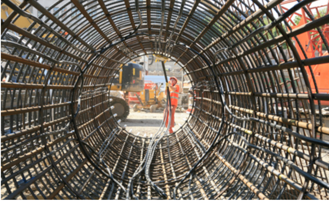
řekil 4.24 : Dolařım boruları yerleřtirilmiř yerinde dkme kazık.
