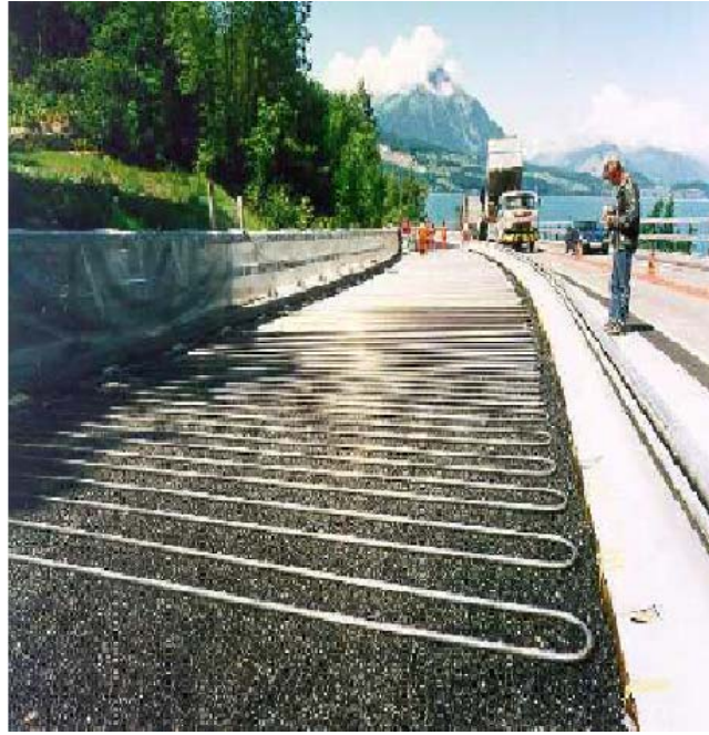
Şekil 4.41 : Geotermal yol kaplaması uygulaması (Kaller,2007).
