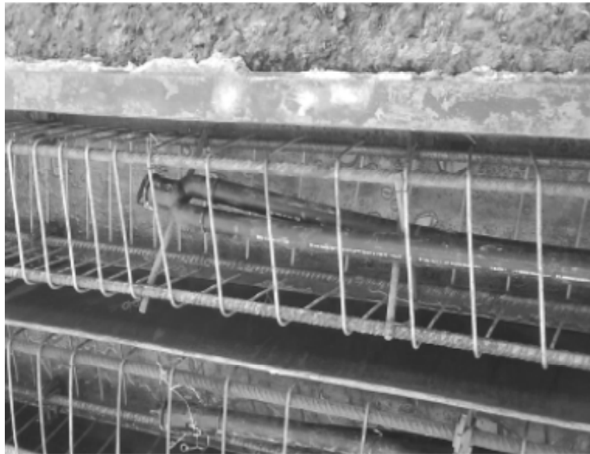
řekil 4.23 : Dolařım boruları ile imal edilmiř prekast enerji kazıėı (Olgun , 2010).
