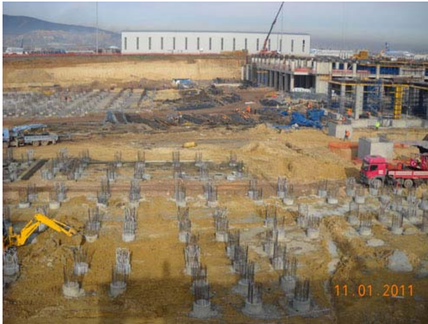
Şekil 5.9 : Betonu dökülen enerji kazıkları.
