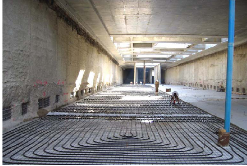
Şekil 4.34 : Geotermal Temel Yapımı (Enerji Döşemesi) (Messe U2 metro istasyonu, Viyana) (Adam&Markiewicz,2009).
