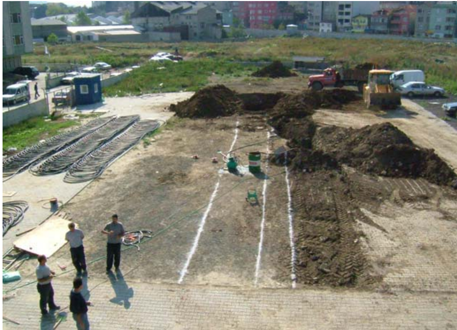
Şekil 5.3 : Isı değiştiricisi hazırlıkları ve hafriyat.
