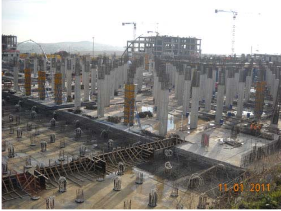
Şekil 5.10 : Kazıklar üzerine binanın inşaa edilmesi.
