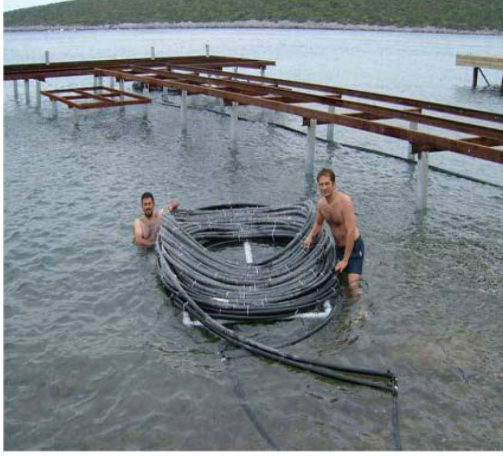
Şekil 4.47 : Dolaşım borularının suya batırılması.
