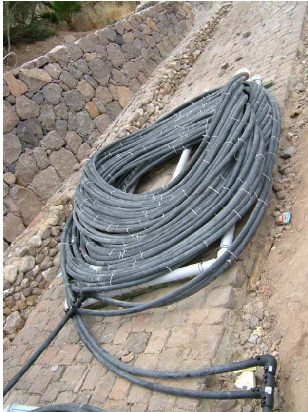
Şekil 5.1 : Uygulama için hazırlanmış deniz ısı değiştiricileri.
