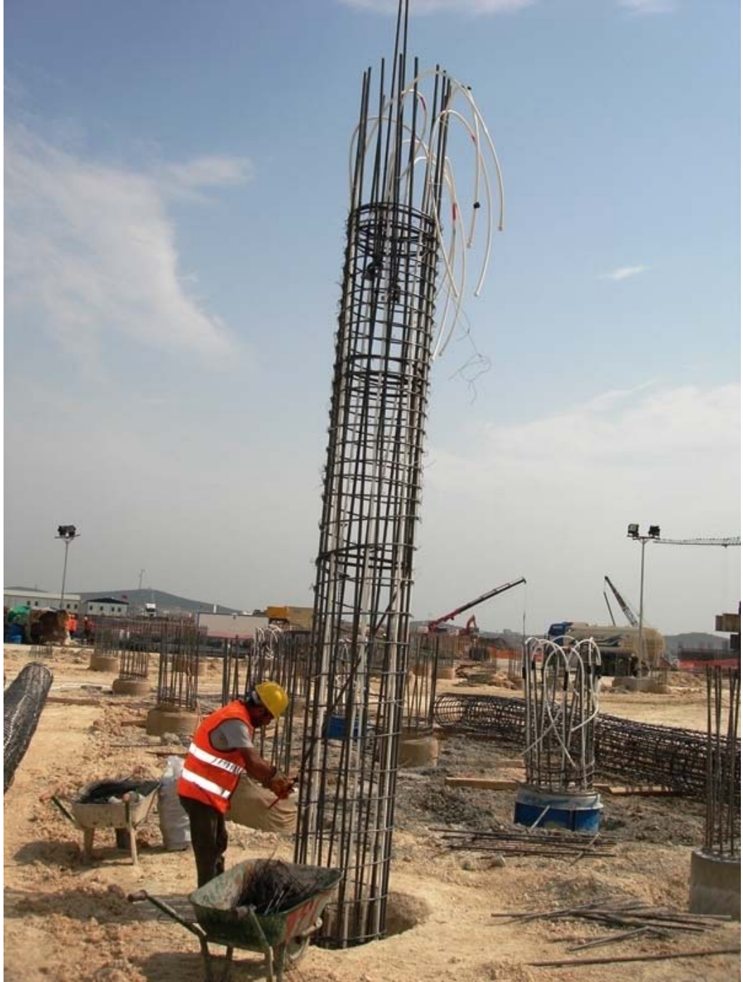
Şekil 5.4 : HABOM enerji kazığı uygulaması.
