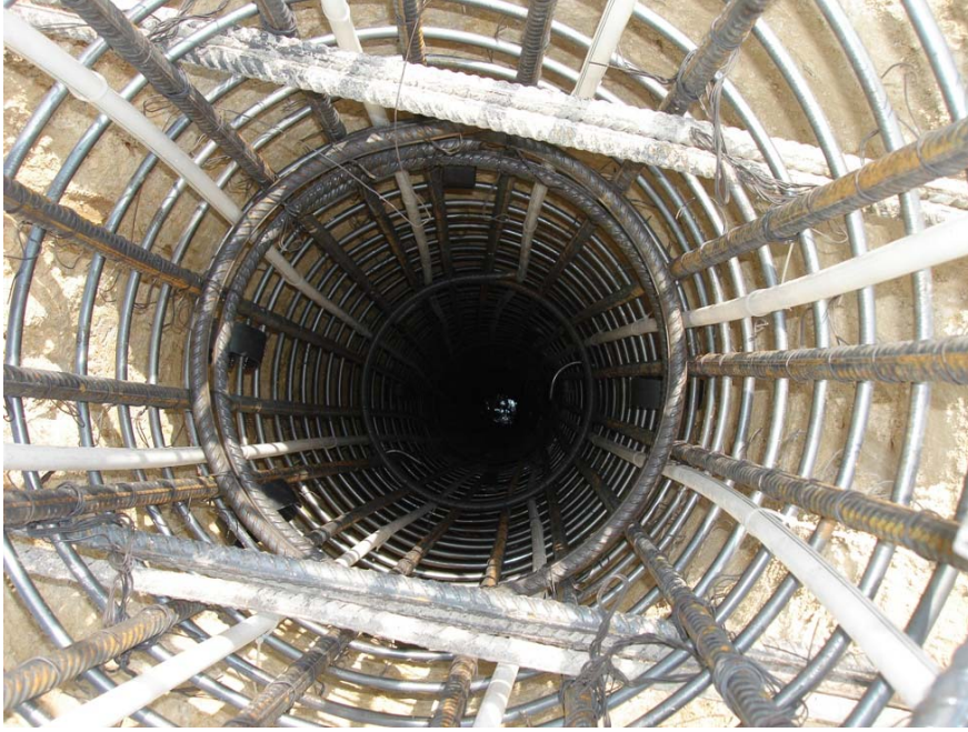
Şekil 5.8 : Enerji kazığının yerleştirilmesi.
