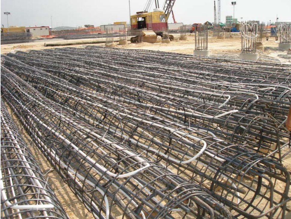
Şekil 5.6 : Dolaşım boruları yerleştirilen enerji kazıklarının istiflenmesi.
