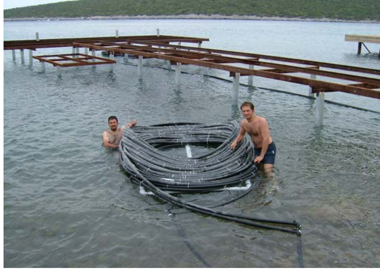
Şekil 5.2 : Borular denize batırılmadan önce.
