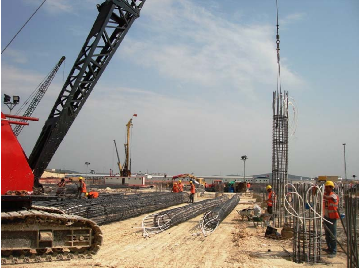
Şekil 5.7 : Kazıkların yerleştirilmesi.
