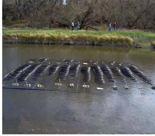
Şekil 4.47 : Dolaşım borularının suya batırılması.
