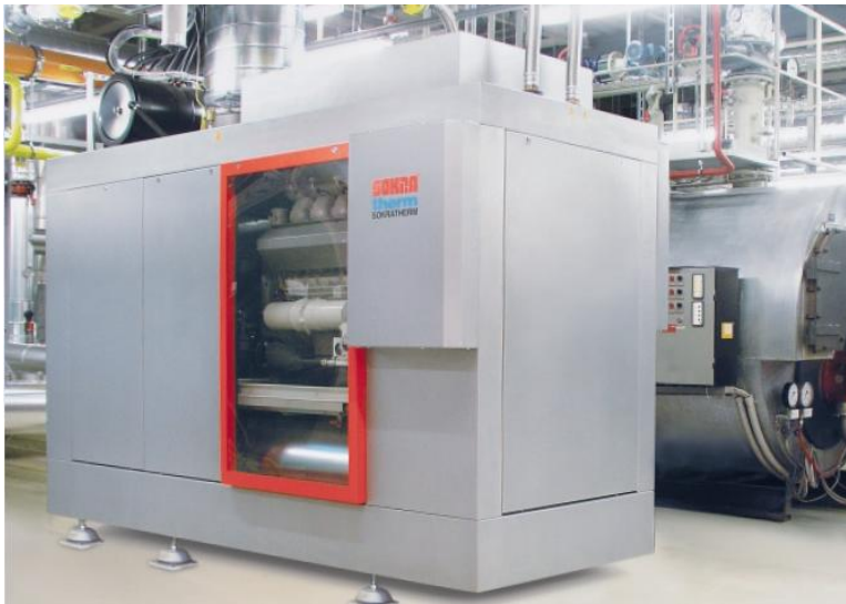
Şekil 3.13 : Paket tip 400 kW e kojenerasyon ünitesi [38].
