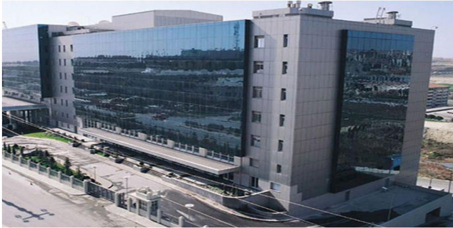
Şekil 7. 7 : Tez kapsamında incelenen bina.
