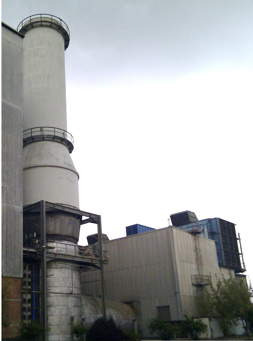
Şekil 2.5 : Gaz türbini bacası.
