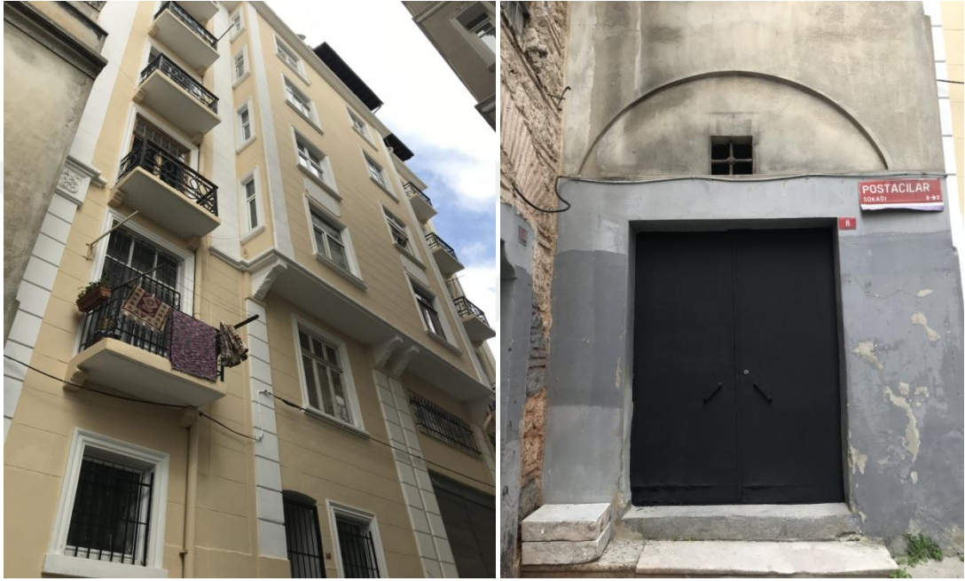
řekil 6.26: Solda6 numaralı Santa Maria Apartmanı, saęda apartmanın hemen solunda yer alan ve kiliseye aılan dięer kapı (Balcı, 2018).
