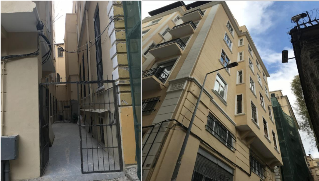
Şekil 6.25: Solda apartmanları ayıran geçit, sağda 6 numaralı Santa Maria Apartmanı (Balcı, 2018).
