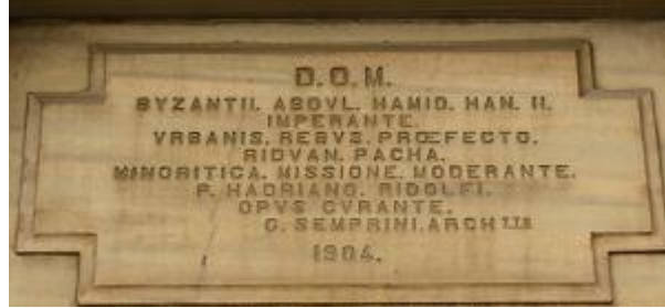
Şekil 6.15: Hanın sağ girişi üzerinde yer alan kitabe (Balci, 2017).
