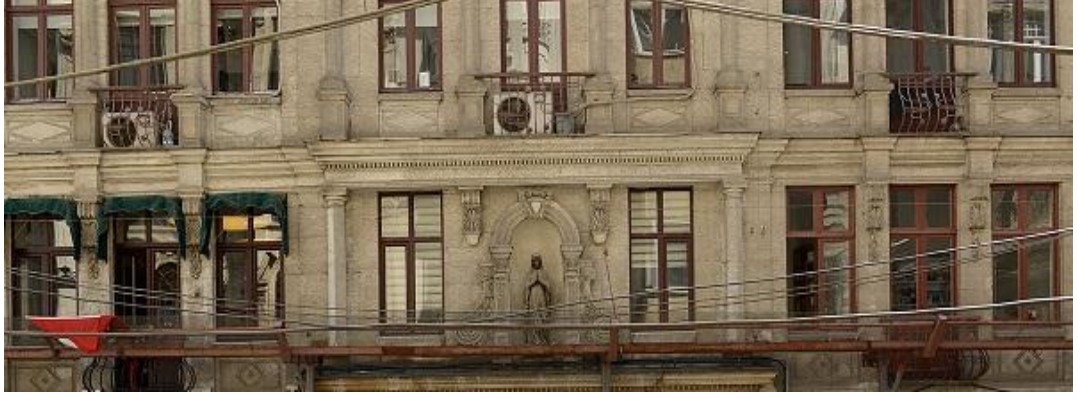
Şekil 6.12: Hanın cephesinden detay (Balci, 2017)
