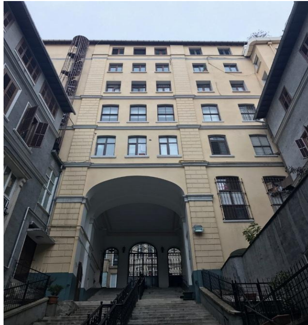
Şekil 6.22: Hanın kilise tarafından arka cephesinin görünümü (Balcı, 2017).
