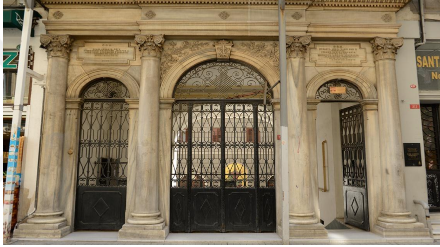
Şekil 6.14 : Hanın kiliseye inen merdivenlerine açılan zafer takı görünümündeki ana kapısı (Balcı, 2017).
