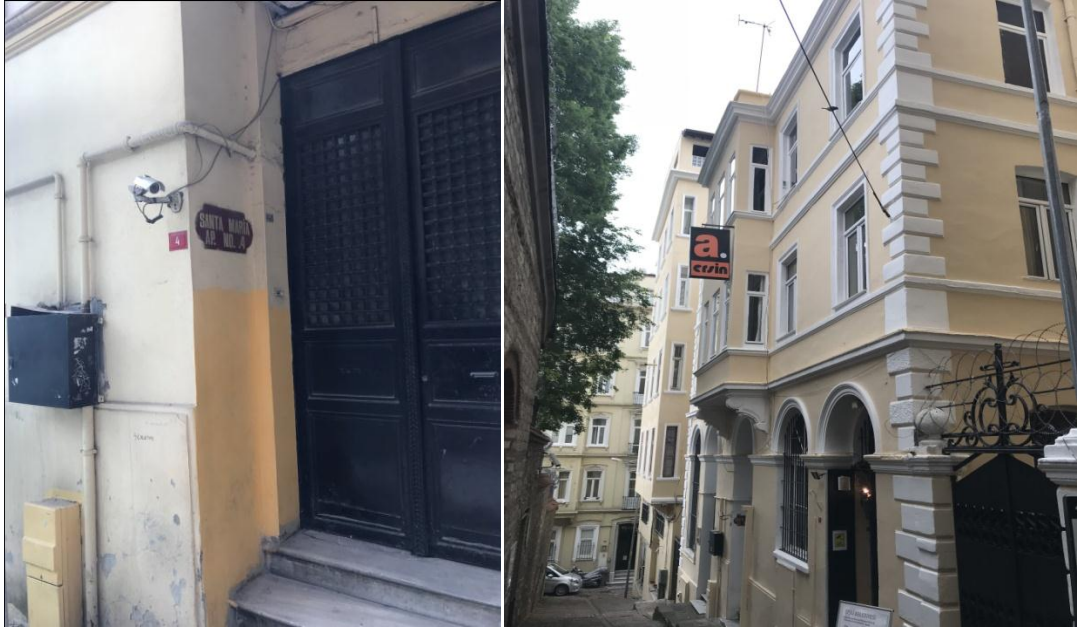
Şekil 6.23: 4 numaralı Santa Maria Apartmanı girişi ve Postacılar Sokağı'na bakan cephesi (Balci, 2018).
