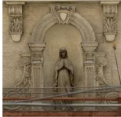
Şekil 6.19 : Hanın İstiklal Caddesi'ne bakan cephesinde yer alan Meryem heykeli (Balcı, 2017).
