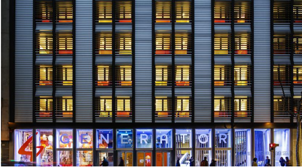
Şekil 3.12 :Generator Hostel – Barselona / İspanya (Url-10)
