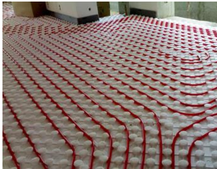
Şekil 4.54 Esnek boru sistemleri ile yerden ısıtma uygulaması [48].
