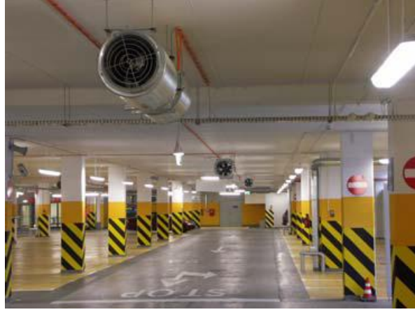
Şekil 3.3 Kapalı bir otoparkta jet fanları [35].
