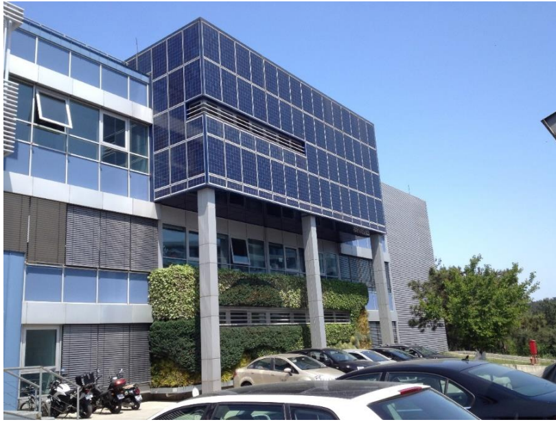
Şekil 1.15 : Arı 6 Enerji Teknokent binasındaki BIPV sistem.
