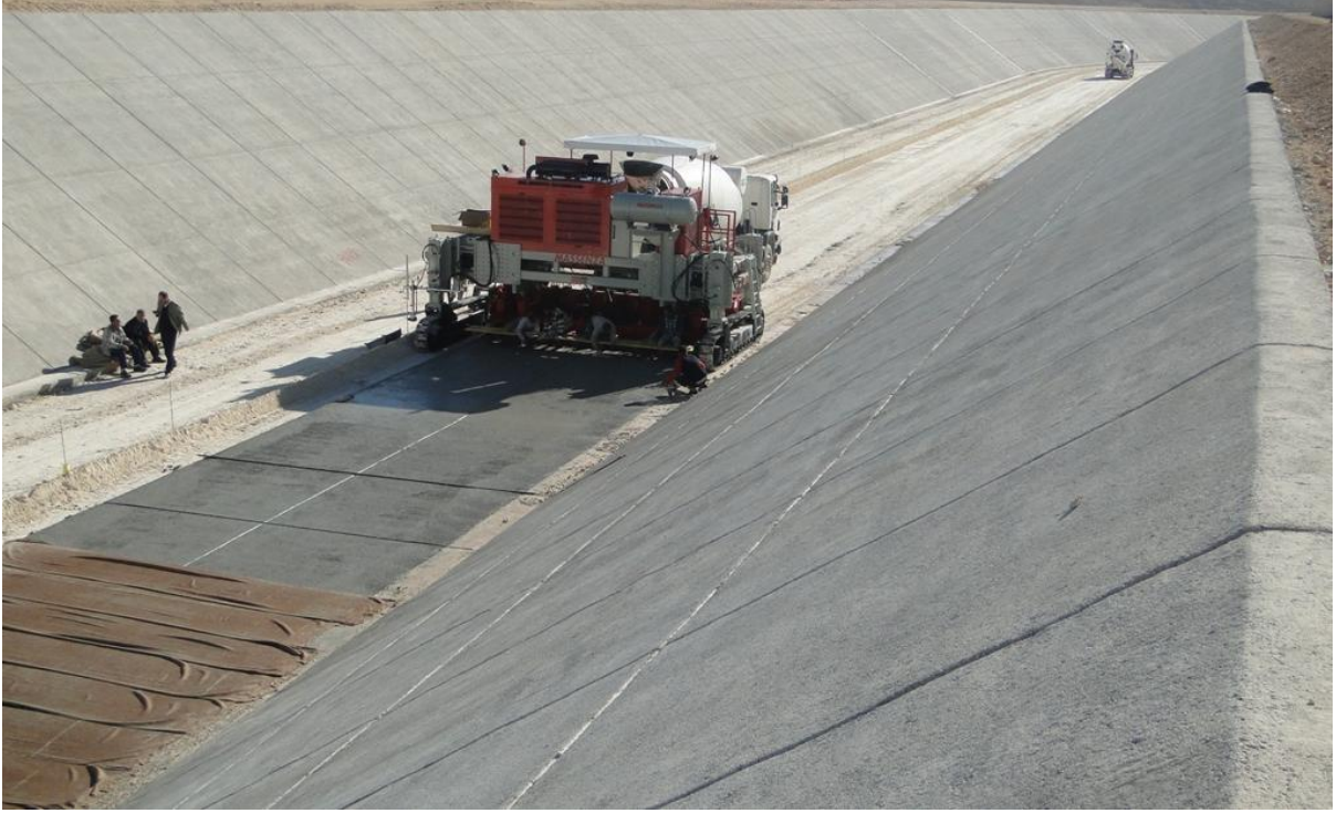
Şekil 3.3 : Şev eğimi doğru yapılmış bir altyapı çalışması (Url-1).
