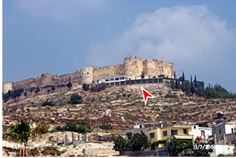
Şekil 5.15 : Silifke Kalesi’nde yapılaşmanın neden olduğu tahribatın boyutları [28].
