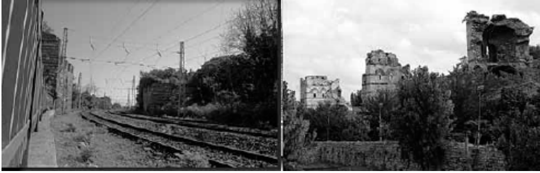
Şekil 5.8 : İstanbul surlarında tahribatın boyutları [27].
