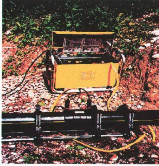
Şekil 5.4: Kaynak süresince ve soğuma süresince pozisyoner kullanımı.
