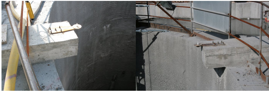
Şekil 9.2 : Şaft üstü kontrol noktaları [38]
