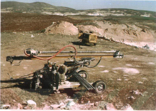
Şekil 6.1 Delme işleminde kullanılan Vagon-Drill
