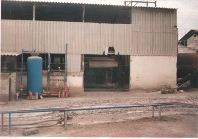
Şekil 3. 2. Döner Fırına Ait Gaz Tankı
