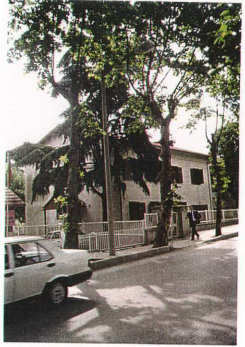
Şekil 5.38. I. Levent’de kuzey cephesinden bir binanın görünüşü
