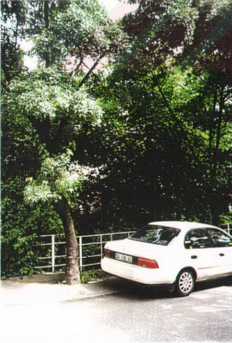
Şekil 5.35. I. Levent'de doğu cephesinden bir binanın görünüşü
