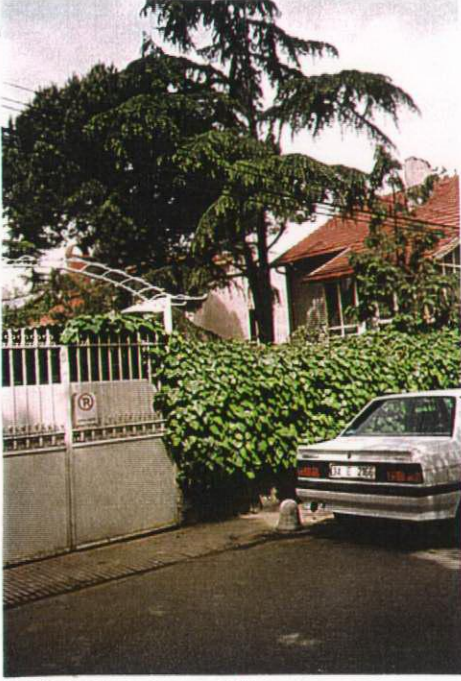
Şekil 5.33. I. Levent'de kuzey cephesinden bir binanın görünüşü
