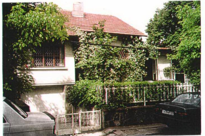
Şekil 5.36. I. Levent'de doğu cephesinden bir binanın görünüşü
