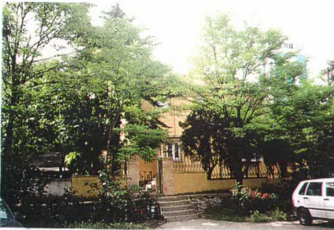
Şekil 5.39. I. Levent’de kuzey cephesinden bir binanın görünüşü
