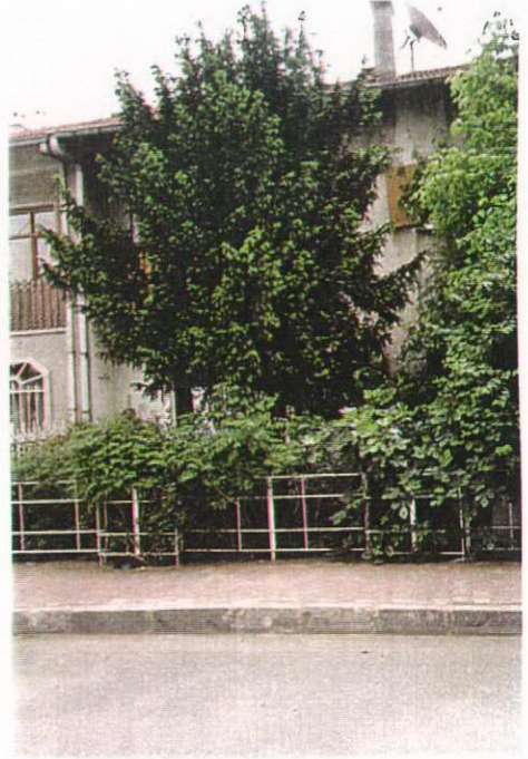
Şekil 5.34. I. Levent'de doğu cephesinden bir binanın görünüşü
