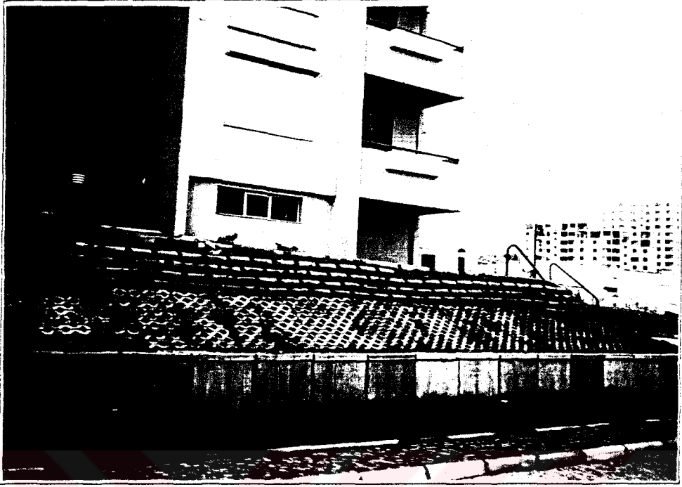
Şekil 4. 74. Ataşehir Uydukent Yerleşmesi'nde Kullanılan İstihnat Duvar Amacı ile Kullanılmış Beton Bloklar
