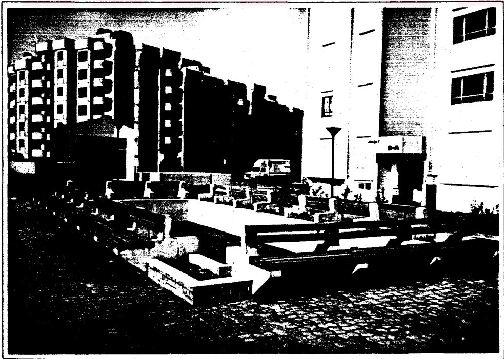
Şekil 4.45. Ataşehir Uydukent Yerleşmesi'nde Yeraltı Otoparkının Aydınlatma Boşluğunun Etrafını Çevreleyecek Şekilde Düzenlenmiş Bir Dinlenme Alanı
