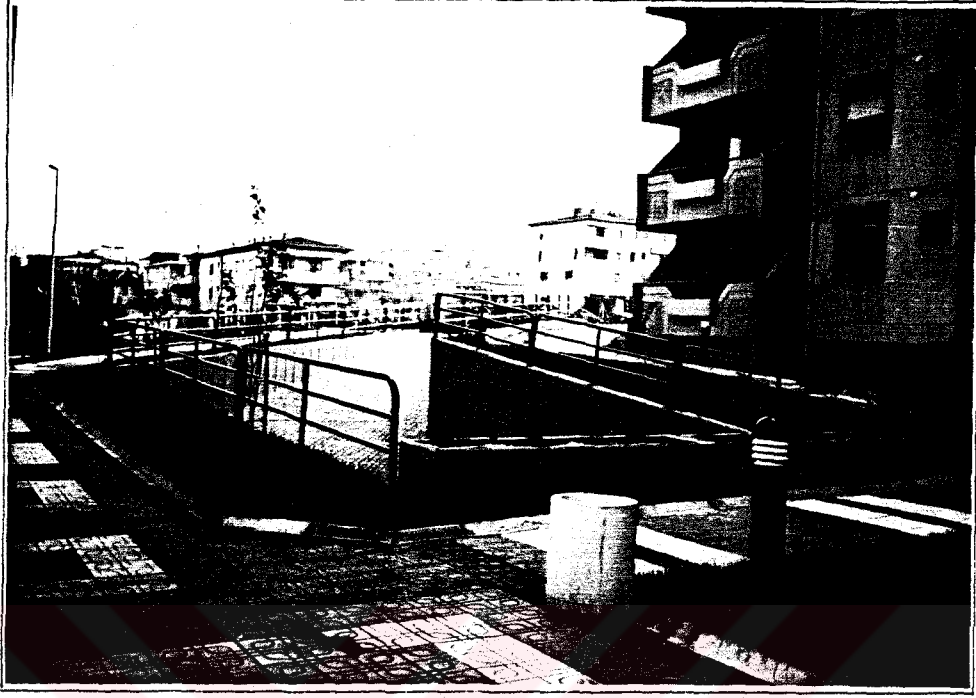
Şekil 4.69. Ataşehir Uydukent Yerleşmesi'nde Yeraltı Otoparkı Girişinden Bir Görünüş
