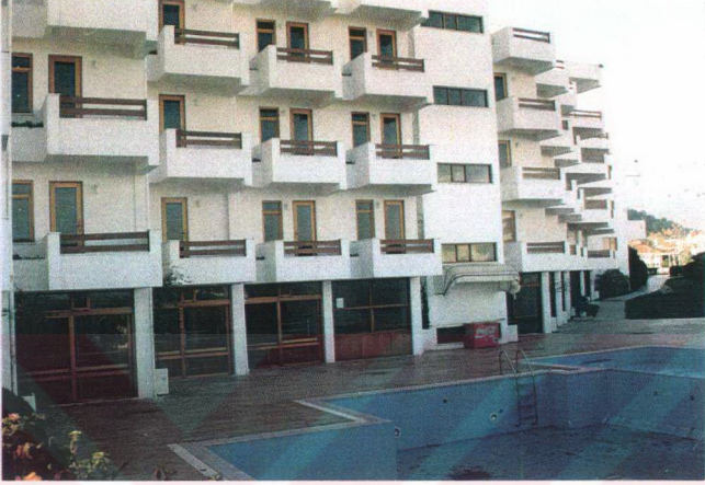
Foto 3.6. 1976 -78 yılları arasında inşaat izni verilen 2. konut yapısı, bugün özel statülü otel
