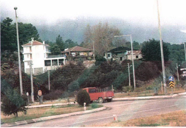
Foto. 4.3. Kemer İmar Planı sınırı içinde ruhsata aykırı uygulamalar
