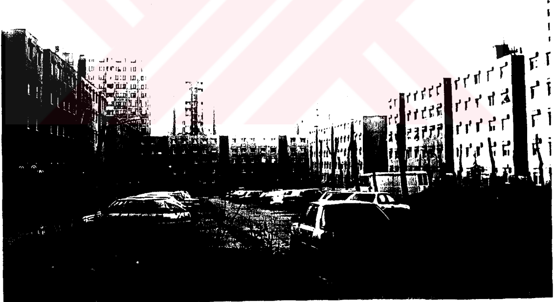
Resim 4.2. Ataköy 9-10. Kısım Alçak Katlı Konut Blokları
