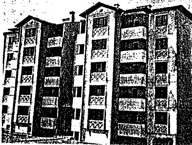
ŞEKİL 3.28. Konutkent-II Sitesinde bloklardan bir görünüm [51]
