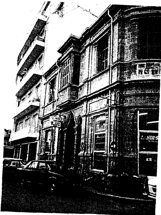
Şekil 4.16. Bölgenin ilk yüksek ve betonarme binası, Mısırlıade Apartmanı
