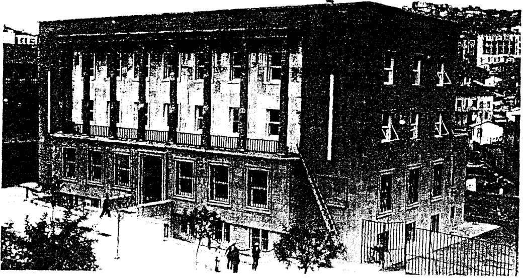
Resim 4.22. Emlak Kredi Bankası, görünüş
