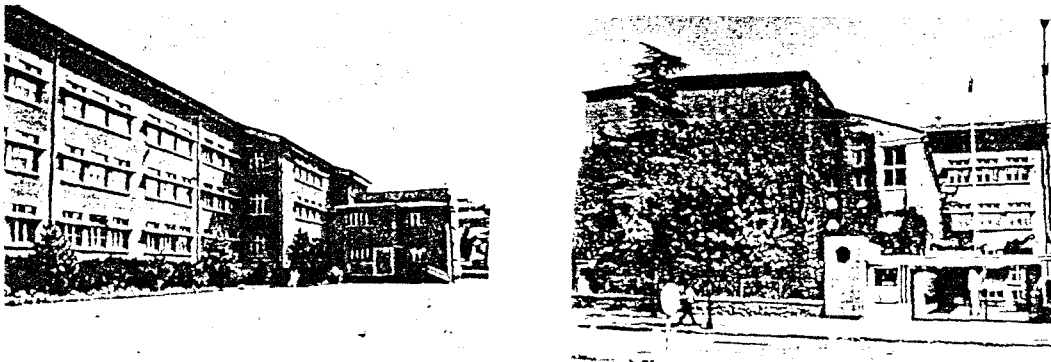
Resim 4.41. Cebeci Orta Okulu, Ankara, 1938. Giriş ve ön cepheden görünüş
